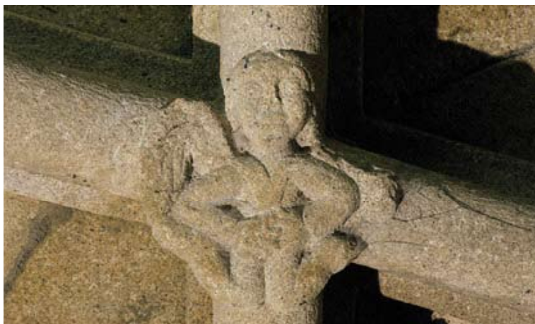
Fig. 19 – O mosteiro de Santa Maria de Aguiar. Sala do capítulo: Chave de abóbada
