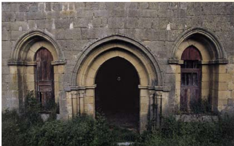
Fig. 17 – O mosteiro de Santa Maria de Aguiar. Fachada da sala do capítulo
