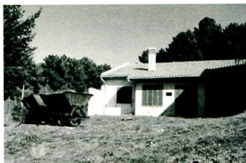
1 – Edifício do antigo Museu do Ferro no bairro mineiro do Carvalhal
