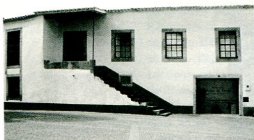
2 – Edifício do Museu do Ferro & da Região de Moncorvo, na solar do barão de Palme, Torre de Moncorvo
