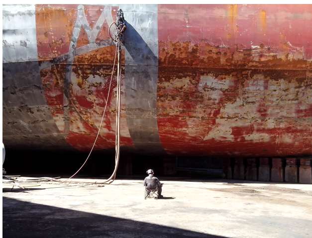
Fig.59. Hidrodecapagem por meio de "robot" nas zonas planas do casco. O operador relativamente afastado, controla a máquina por meio de "joy-stick".
