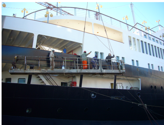
Fig.66. Naval Rocha. Recurso ao bailéu para pintura a rolo, da superestrutura. Fonte: Foto do autor.
