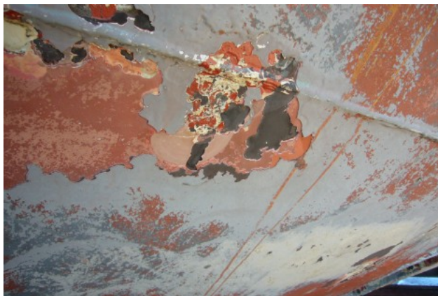
Fig.12. Estaleiro de Peniche, 2014. Fundo vertical de uma embarcação de pesca. Observam-se facilmente as inúmeras camadas de tintas velhas soltas, com graves problemas de aderência por sobresspessura. Apesar do relativamente baixo grau de corrosão, e de acordo com informação do armador, este casco será sujeito a decapagem total do fundo em 2016.
