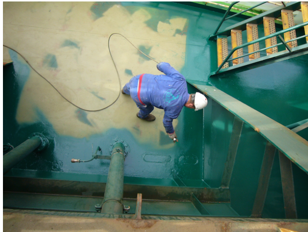
Fig.104. Pintura do convés após hidrodecapagem manual (água doce a alta pressão) a 1300 bar.
