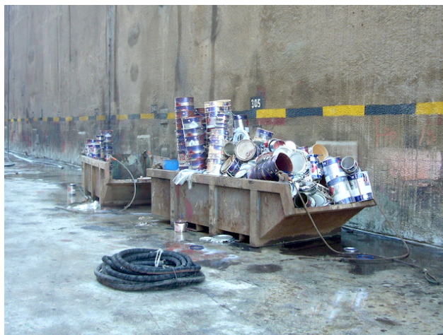
Fig.108. Empilhamento de latas usadas, em contentor apropriado para oportuno encaminhamento e depósito em destino para resíduos sólidos. Fonte: Foto do autor.
