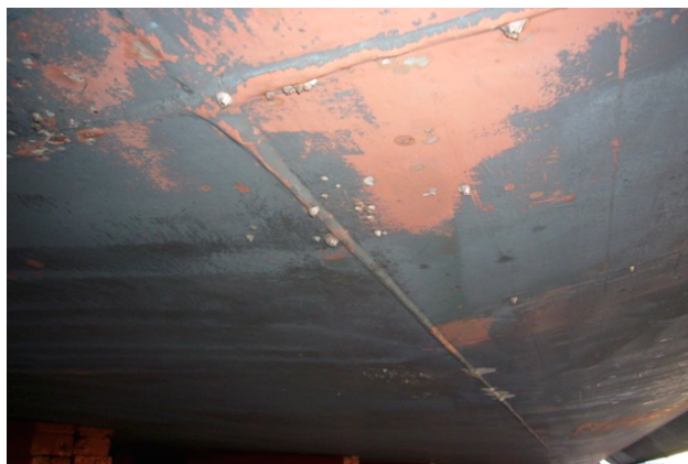
Fig.22. Condição do fundo chato após "LAP". Observam-se algumas cracas residuais, passíveis de fácil remoção por raspagem manual, bem como uma grande extensão de primário em virtude do acentuado desgaste da película de "A/F" vermelho, autopolimentante.
