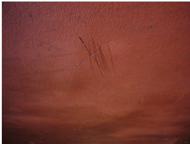
Fig.42. "X cut". Em caso de dúvida, por defeitos ou excesso de tintas velhas que possam comprometer o seu recobrimento com tinta nova, efectua-se com um simples "x-acto", pequenos cortes profundos em “X” na superfície após "LAP", para comprovar e assegurar o grau de aderência com segurança, podendo igualmente ser praticado o denominado “cross-cut” (quadrícula), de acordo com as normas adequadas.
