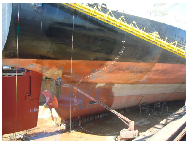
Fig.67. Lavagem após entrada em doca. Pormenor da utilização de uma "Cherry Picker". Pode-se observar a sua versatilidade com movimento tipo telescópico da lança/extensão do braço, permitindo alcançar facilmente todos os pontos do casco. Fonte: Foto do autor.
