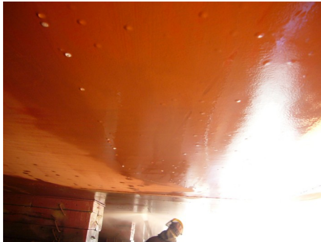
Foto.39. Conclusão da lavagem a alta pressão do fundo chato e simultâneamente, remoção de todas as incrustações animais e vegetais. Fonte: Foto do autor.
