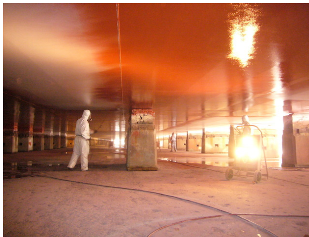
Fig.27. Aplicação de Silicone vermelho de acabamento no fundo chato. Mesmo sob boas condições de iluminação o pintor poderá ser encadeado pelos projectores, daí a vantagem da utilização de cores contrastantes neste tipo de ambientes. A sua progressão efectua-se andando para trás para melhor controlo do trabalho.
