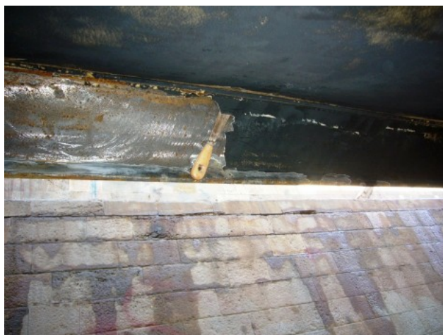
Fig.15. Robalete de um navio aparentando bom estado de revestimento. Porém, observam-se graves problemas de aderência até ao substracto por deficiente tratamento de superfície não decapada e portanto sem perfil de ancoragem/rugosidade adequada.
