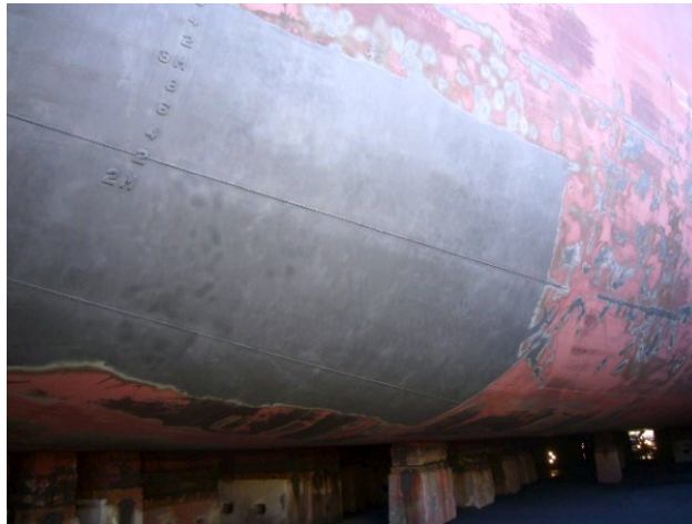
Fig.58. Decapagem manual seguida, ao grau Sa 2 ½ da zona do delgado de proa. As restantes zonas corroídas do fundo vertical foram decapadas em "spots" Sa 2 ½. Fonte: Foto do autor.
