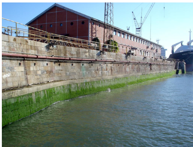
Fig.5. Doca 2, Naval-Rocha, Lisboa. Desenvolvimento de incrustações de origem vegetal ao longo das paredes da doca após 57 dias de exposição continuada e directa ao meio aquático.
