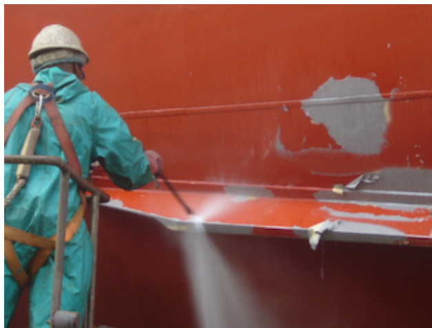
Fig.101. Remoção por "LAP" da película de primário epoxídico em excesso, sem aderência, sobre o silicone residual do casco. Fonte: Foto do autor.
