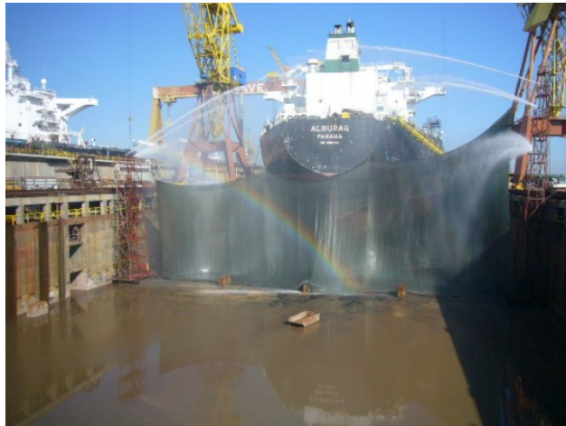
Fig.107. Lisnave Mitrena, doca 22. Instalação de uma tela e de cortinas de água, para protecção contra poeiras geradas durante as operações de decapagem do casco. Fonte: Foto do autor.
