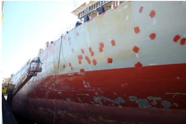
Fig.69. Aplicação da primeira demão de retoques de primário na decapagem em "spots" ao grau Sa 2 ½.
