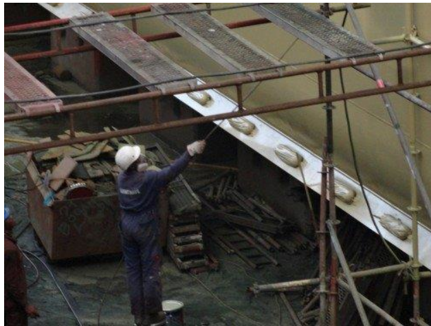
Fig.77. Protecção dos ânodos de alumínio no robaletes, com fita isoladora. Fonte: Foto do autor.
