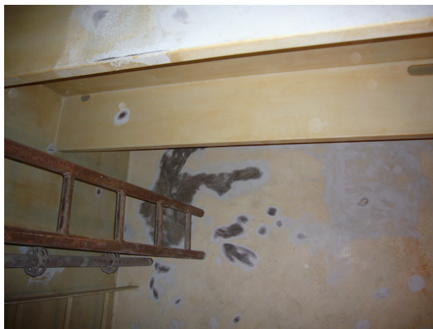
Fig.103. Tratamento mecânico em "spots" ao grau St3 nas zonas com corrosão, de tanques de água doce. Fonte: Foto do autor.
