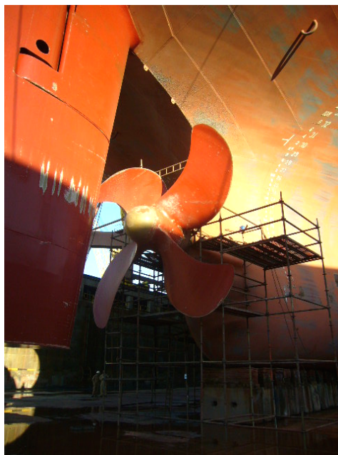
Fig.98. Montagem de andaimes para reparação da pintura do hélice particularmente nos rebordos das pás e no "nariz". Neste caso o próprio leme, igualmente revestido por silicone, foi também objecto de tratamento localizado nas zonas danificadas.
