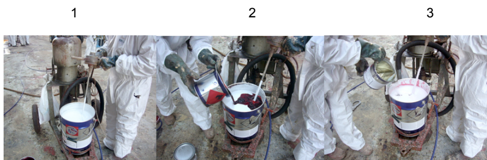
Fig.71. "Tie-coat" de três componentes. Fases distintas da mistura: 1- base branca (Nexus); 2 - mistura com o aditivo (avermelhado); 3 - adição do agente de cura (incolor).
