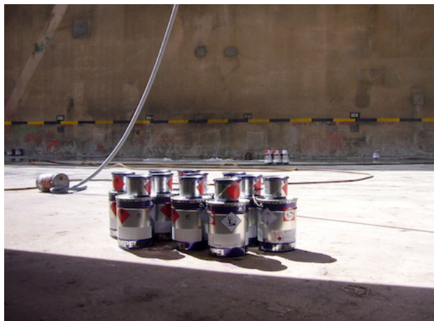
Fig.93. Divisão de latas para aplicação de “A/A” de silicone. No primeiro plano, tinta com o respectivo agente de cura, para uma secção do fundo chato; no segundo plano tinta para um segmento do fundo vertical. No plano mais afastado, podem-se observar as marcas/cotas no fundo da doca, muito úteis como referências. Fonte: Foto do autor.
