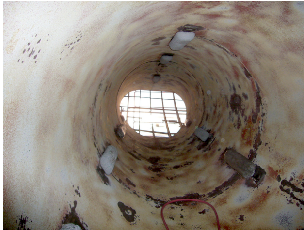
Fig.56. A mesma zona da foto anterior, após operação de "gritsweeping" ou varrimento com jacto abrasivo sem grau definido (granalha/escória de cobre). Fonte: Foto do autor.
