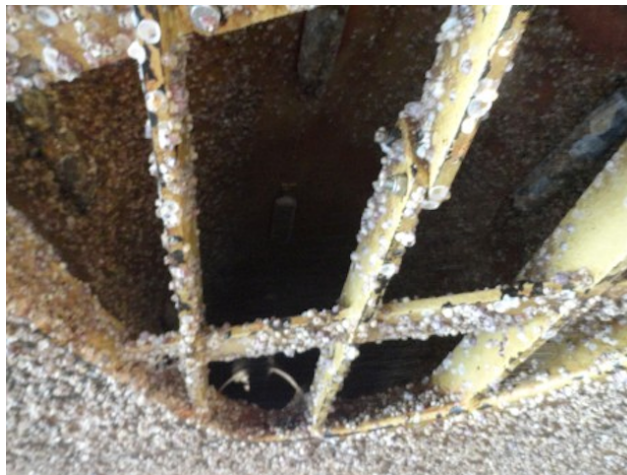
Fig.4. Grelha de um ralo de fundo. Inscrustações de marisco com bases calcárias. Fonte: Foto do autor.
