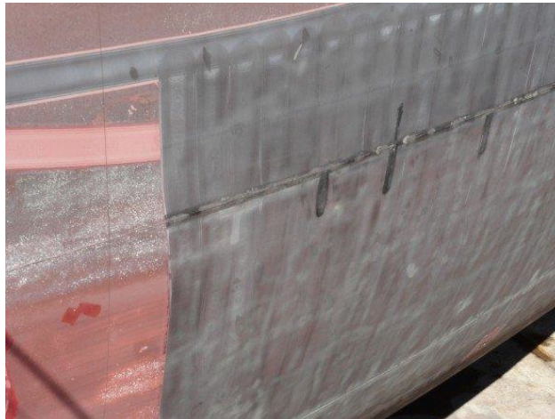
Fig.61. Pormenor da hidrodecapagem no fundo vertical. Observam-se alguns “queimados” produzidos por trabalhos de soldadura na face interior do casco, nos tanques laterais de lastro.
