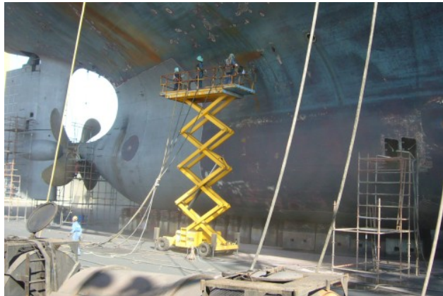
Fig.64. Plataforma elevatória articulada normalmente conhecida por "Tesoura", utilizada neste caso para trabalhos de decapagem. Fonte: Foto do autor.
