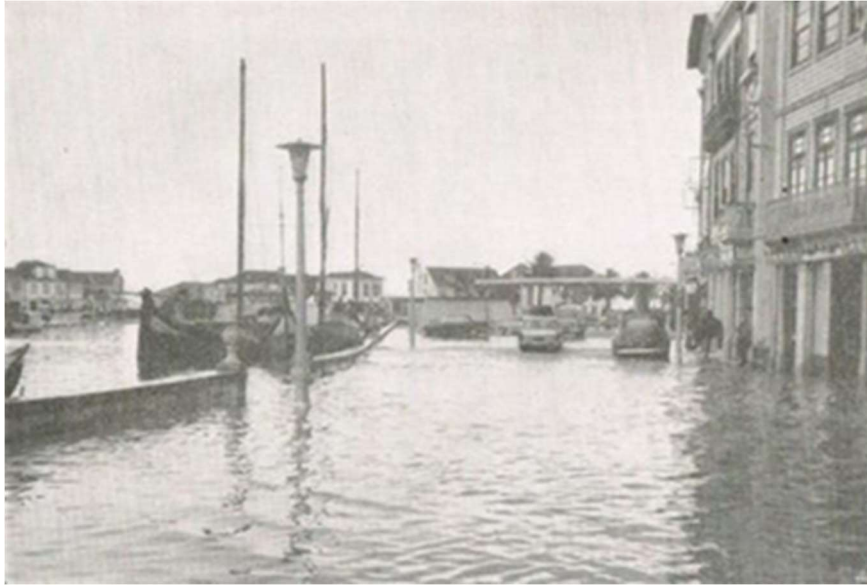
Figura 34 - Cheia de 1964, na Rua João Mendonça | Fonte: (IMAGEOTECA, 2023)
