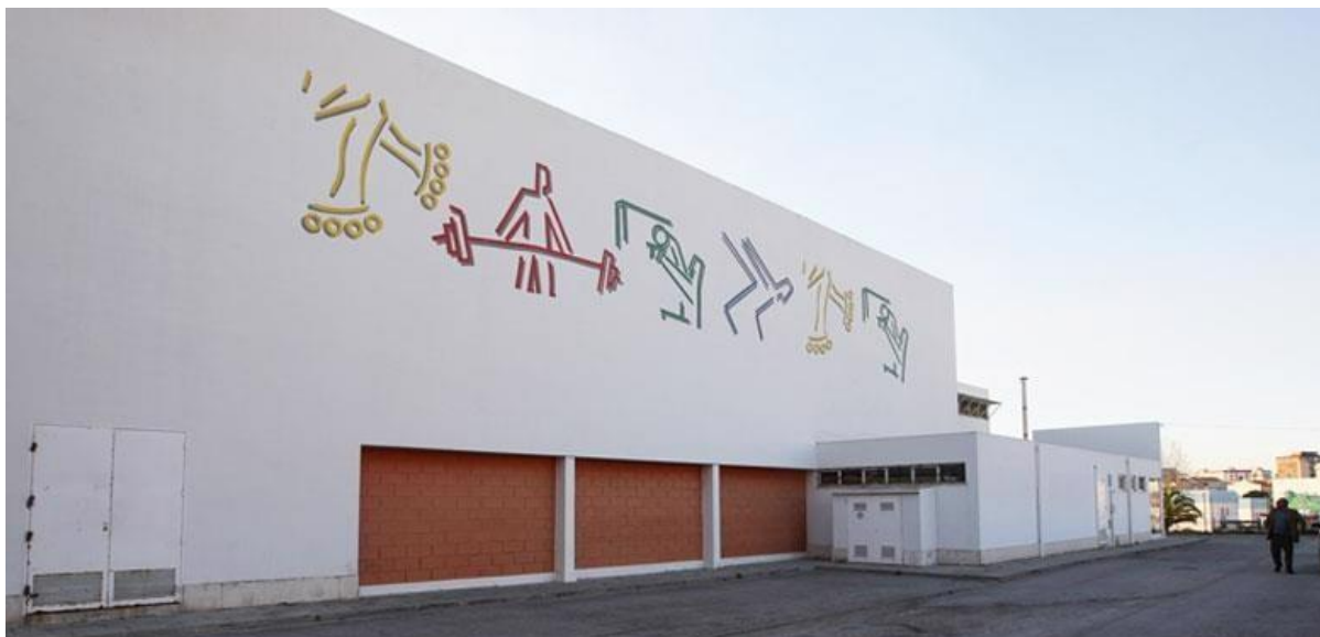
Figura 5- Pavilhão (vista exterior)
