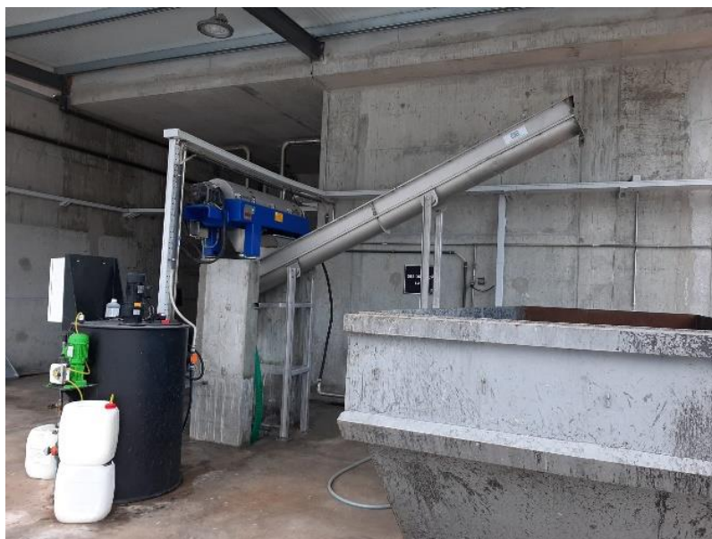
Figura 18: Centrífuga para desidratao de lamas
