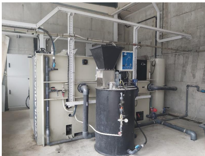
Figura 14: Sistema de tratamento primrio DAF
