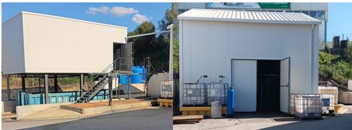
Figura 10.1 – Estação de Tratamento de Águas Residuais Industriais da SRAMPORT.
