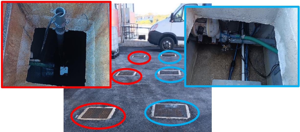
Figura 10.2 – Tampas de visita dos tanques destacadas a vermelho, a azul estão destacadas as tampas de visita das bombas.
