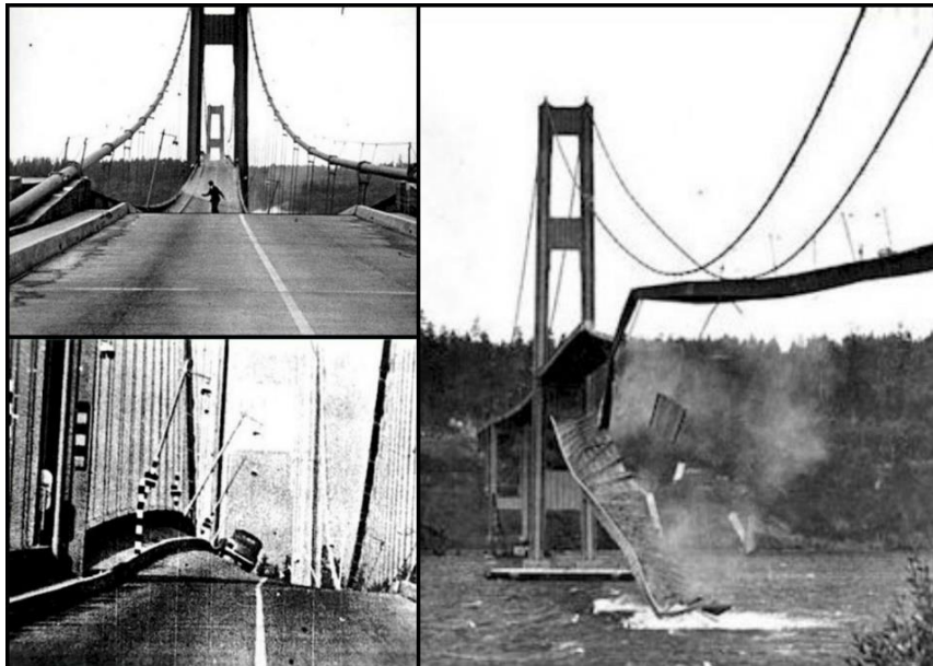
Figura 4 - Ponte Tacoma Narrows durante o fenómeno de ressonância causado pelo vento. A ponte tinha sido inaugurada aproximadamente 4 meses antes do sucedido, em 1940. [5] (Imagens retiradas de Farquharson, da Coleção de Fotografia Histórica, das Bibliotecas da Universidade de Washington).
