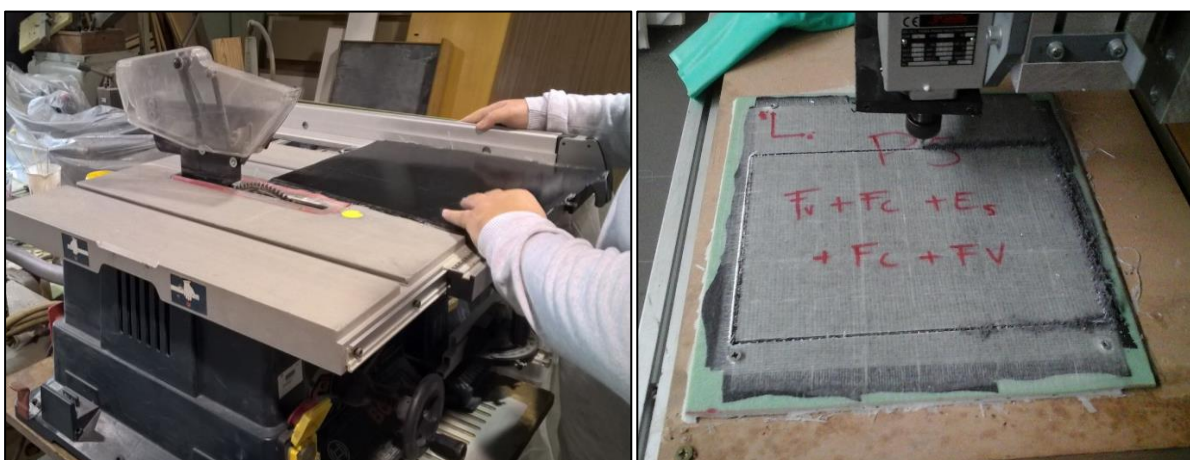
Anexo 2.6 - Esq : Placa a ser cortada com a Rebarbadora; Dir : Placa a ser cortada com a Máquina de CNC;
