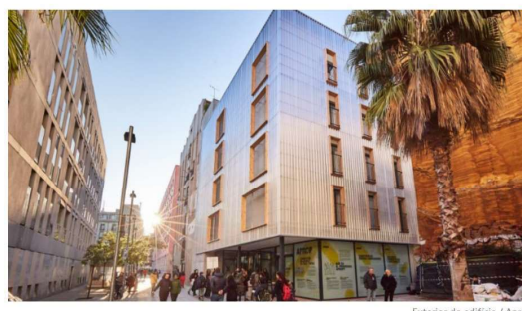
Figura 4 - Exemplo de habitação modular com contentores marítimos reutilizados - Edifício de construção social em Barcelona Fonte: (6)
