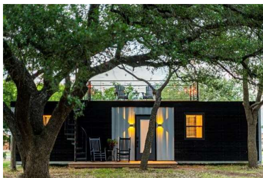
Figura 6 - Exemplo de moradia modular construída com contentores marítimos reutilizados Fonte: (11)
