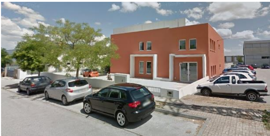
Figura 2.2: Instalações da Active Space Technologies S.A.
