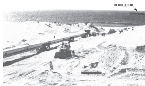
FIGURA 13 Exutor submarino pronto para ser lançado no mar. A seta indica o rebocador, ao largo.
