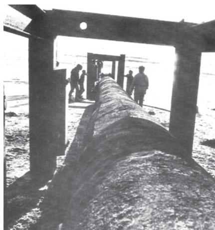
FIGURA 4B Celnorte – Aspecto da construção do exutor submarino. L = 2 Km; Ø = 1100
