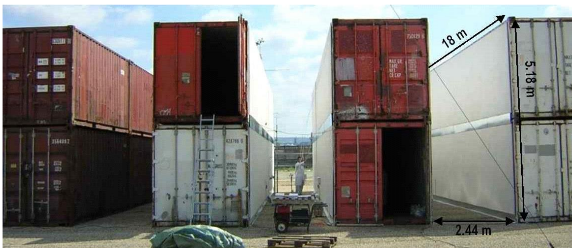
Figura 23: Instalação da rua piloto [PICADA PROJECT, 2005]
