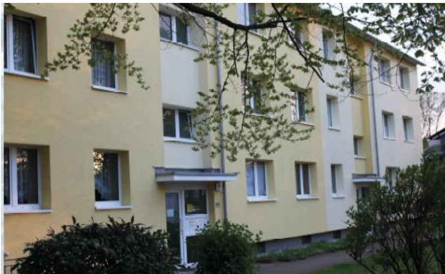
Figura 34: Edifício residencial em Leverkusen, Alemanha. A aplicação foi feita em 2012. [NADICO, 2002]
