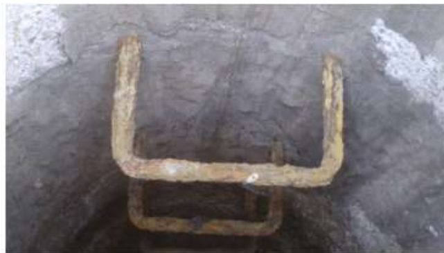
Figura 38 - Degrau em varão de aço DN 12mm – interior de câmara de visita
