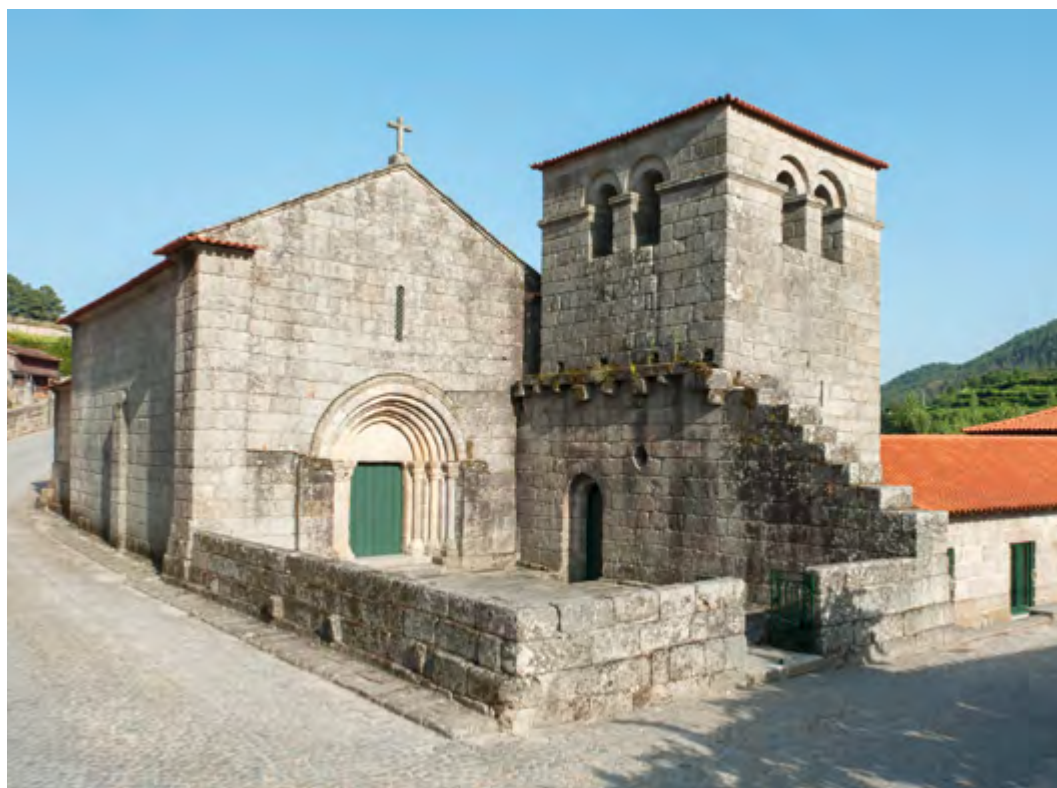
Igreja. Fachada ocidental e torre sineira.
