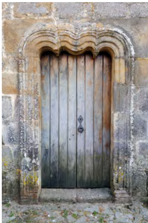
Igreja. Fachada norte. Nave. Portal.
