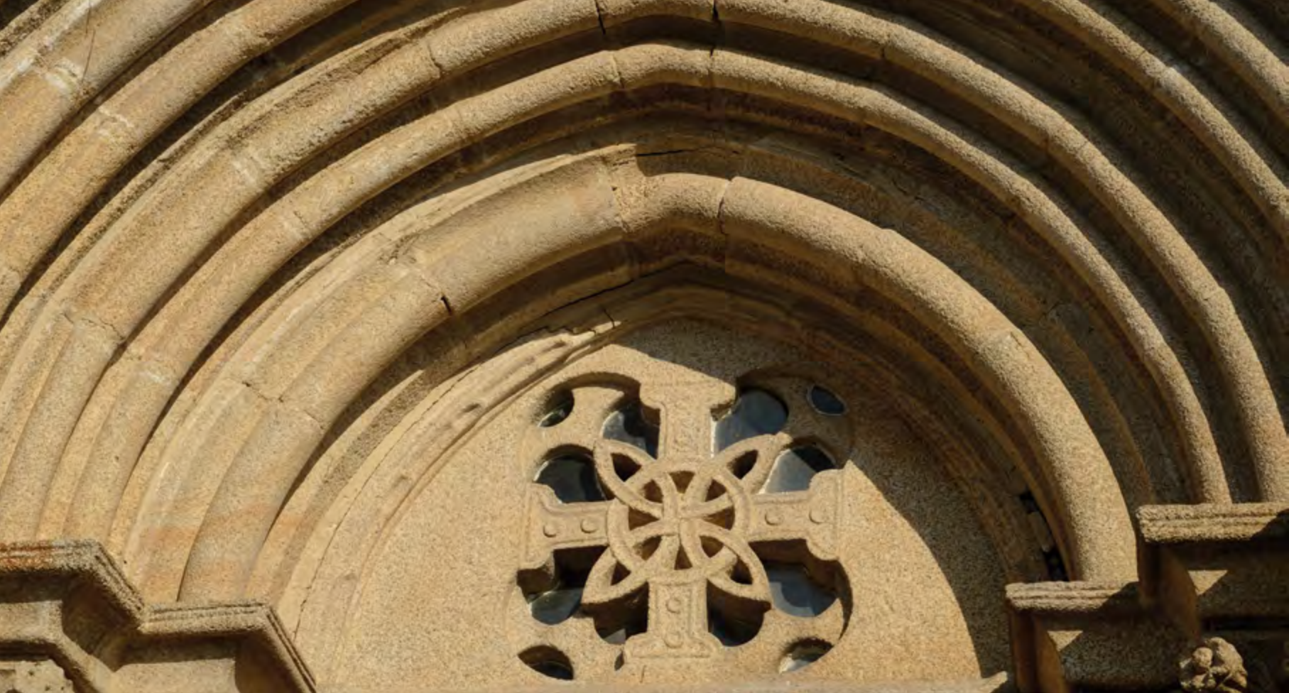
Fachada ocidental. Portal. Tímpano.
