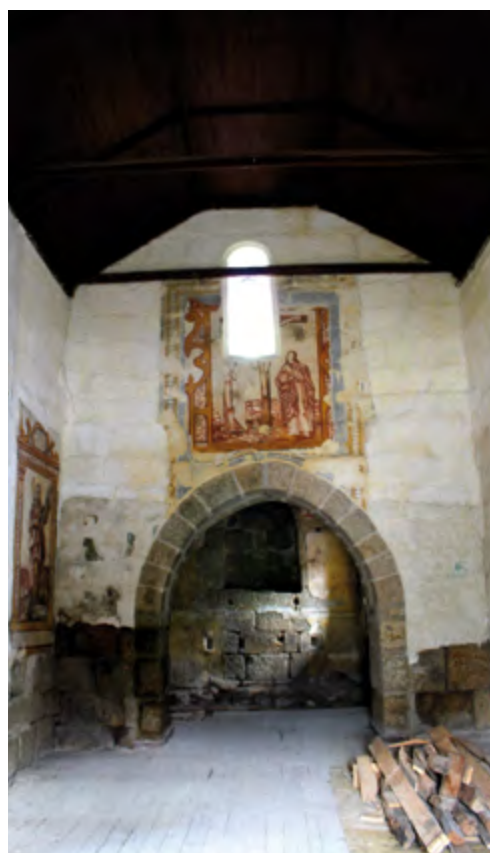
Nave e capela-mor durante as intervenções da Rota do Românico (2013).
