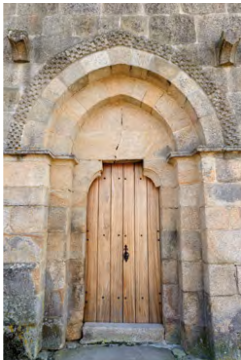
Fachada norte. Nave. Portal.
