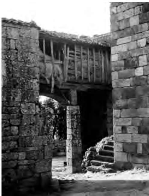
Passadiço existente sobre o arco que ligava a "Casa do Caseiro" ao "Conventinho" antes das intervenções da DGEMN (1955). Fonte: arquivo IHRU.
