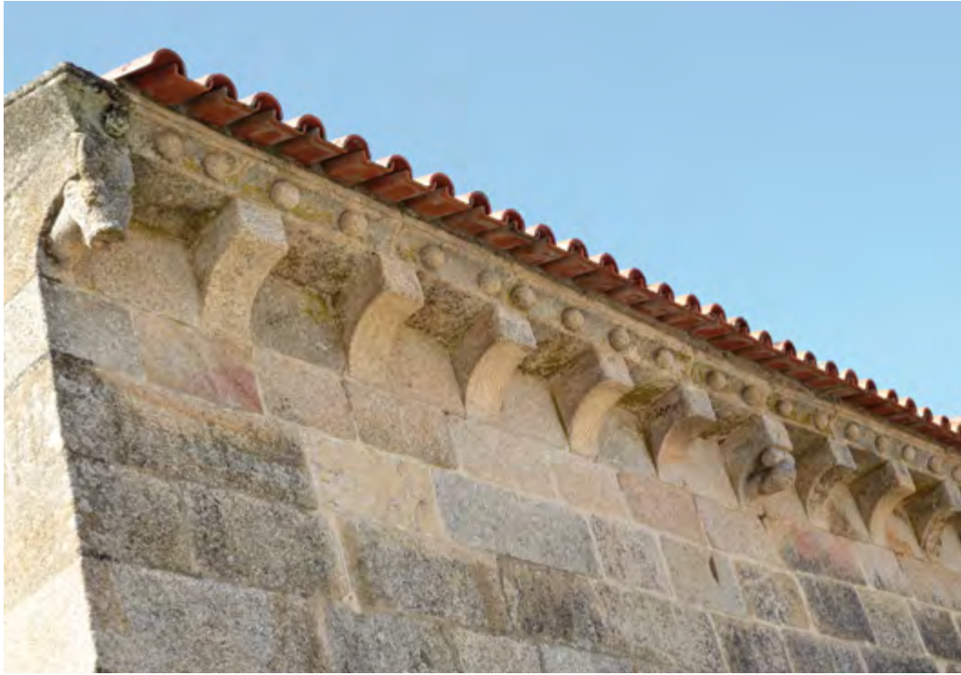
Fachada norte. Capela-mor. Cachorros.
