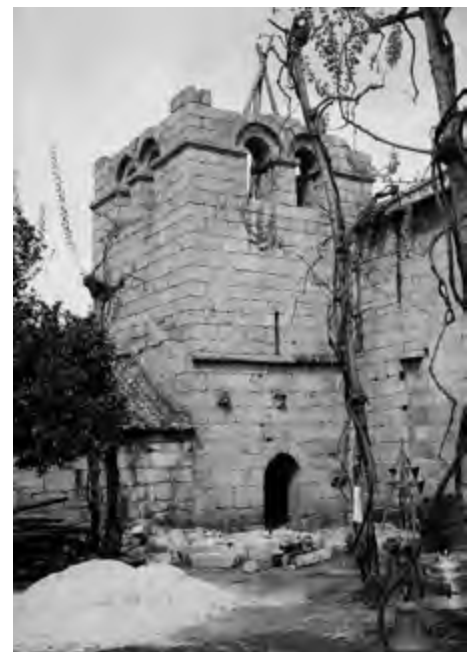
Igreja. Obras de reparação do coroamento da torre. Fonte: arquivo IHRU.
