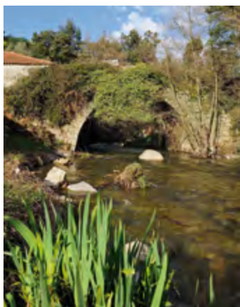
Vista de jusante.
