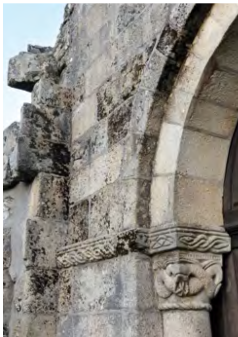
Fachada ocidental. Portal. Lado norte. Impostas e capitel.
