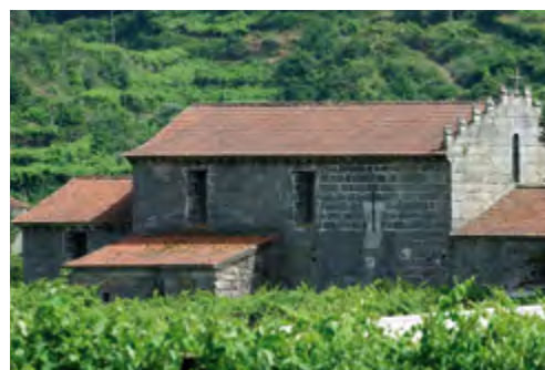
Igreja. Fachada norte.
