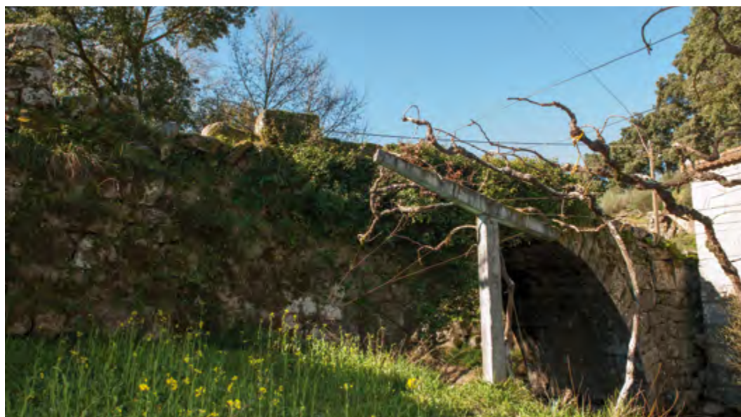
Vista de montante.
