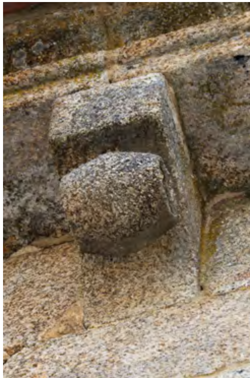
Fachada norte. Nave. Cachorro.
