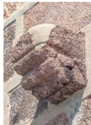
Fachada sul. Mísula.
