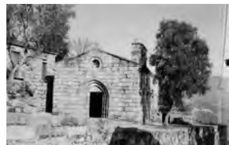
Vista geral antes das intervenções da DGEMN (1986). Fonte: arquivo IHRU.
