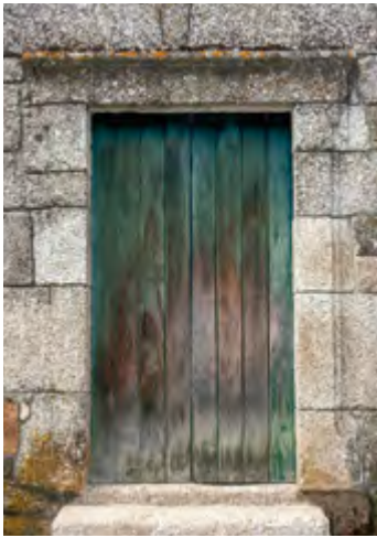
Igreja. Fachada sul. Nave. Portal.
