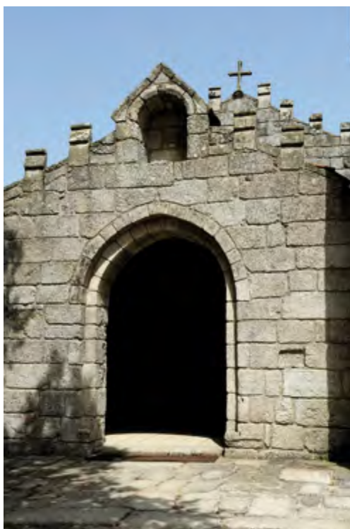
Igreja. Fachada ocidental. Galilé. Vista exterior.
