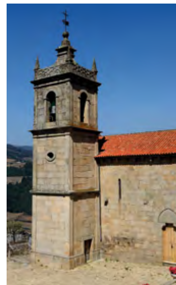
Fachada sul. Torre sineira.
