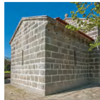
Fachadas oriental e norte. Capela-mor.
