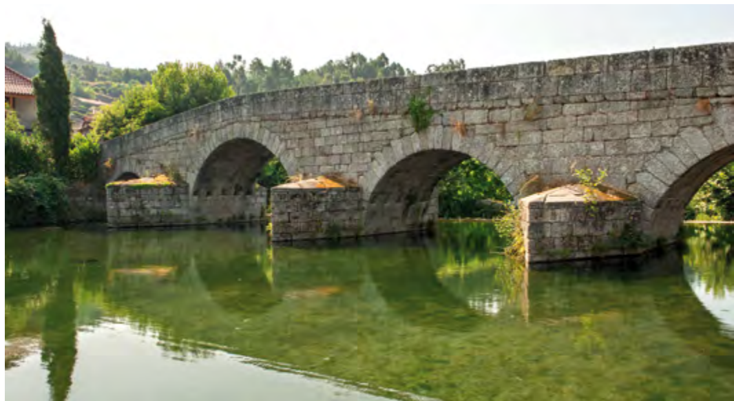
Vista de montante.
