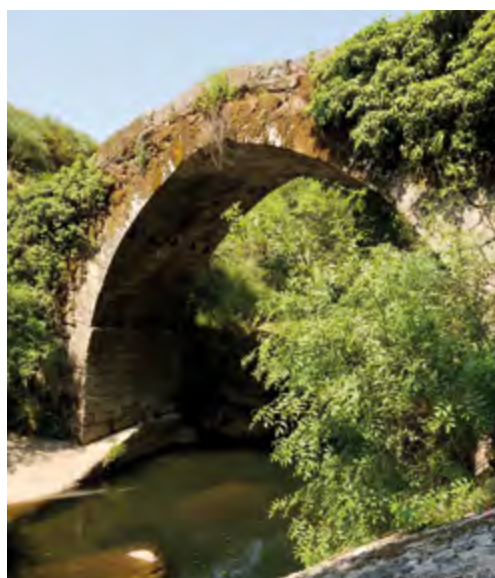
Vista de jusante.
