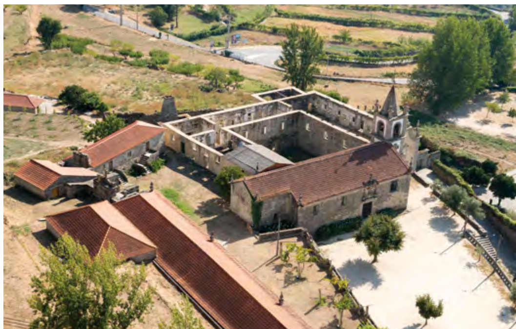
Mosteiro de Ancede (Baião). Vista aérea.
