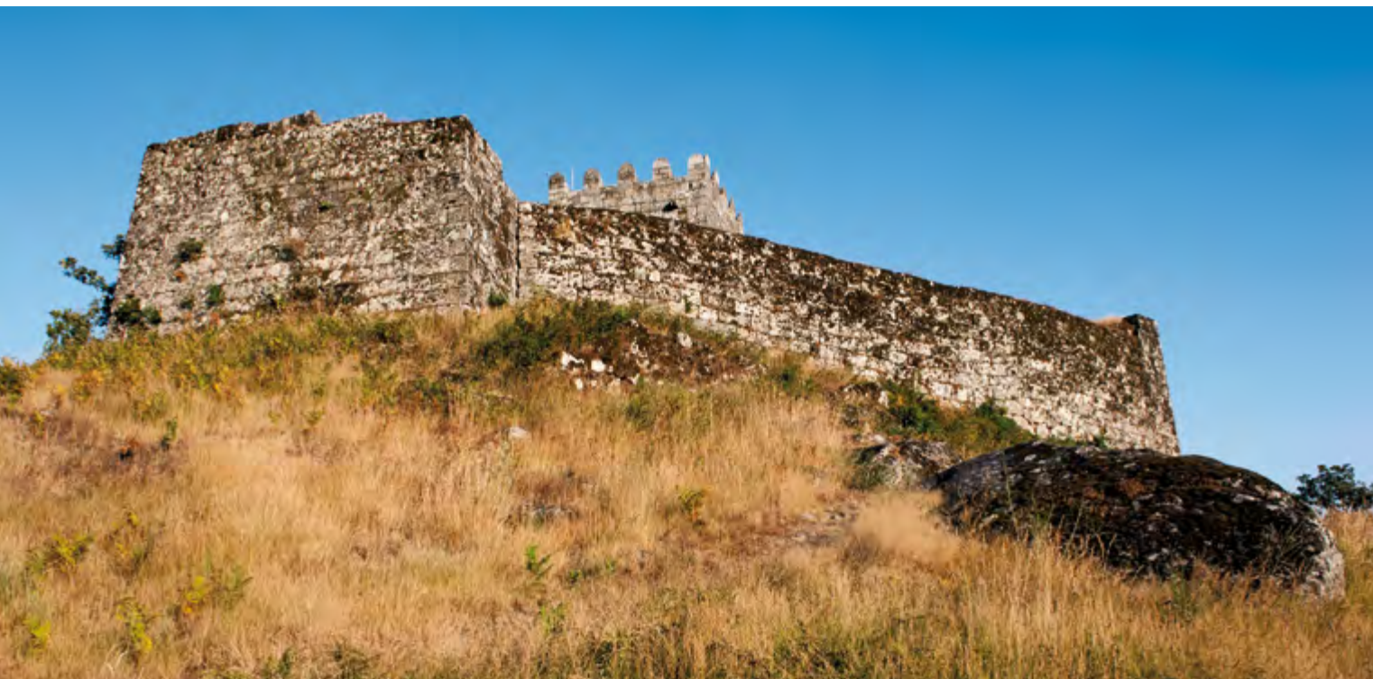
Vista de norte.
