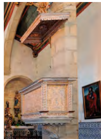
Igreja. Nave central. Púlpito.
