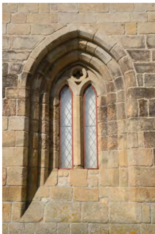
Igreja. Fachada oriental. Janela mainelada.
