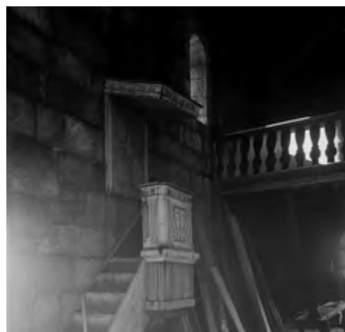
Igreja. Obras de apeamento do coro alto. Fonte: arquivo IHRU.
