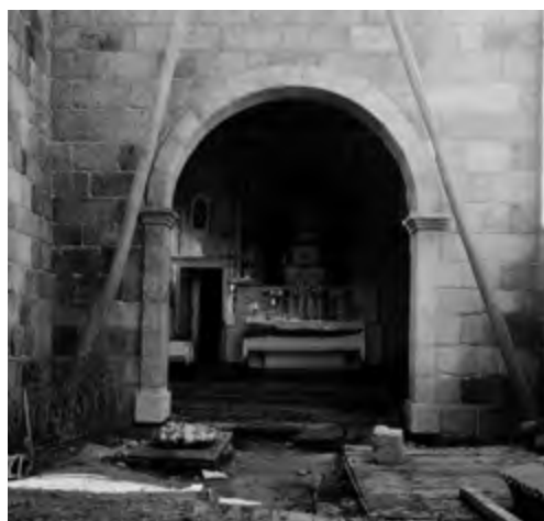
Igreja. Obras de remoção do reboco interior. Fonte: arquivo IHRU.
