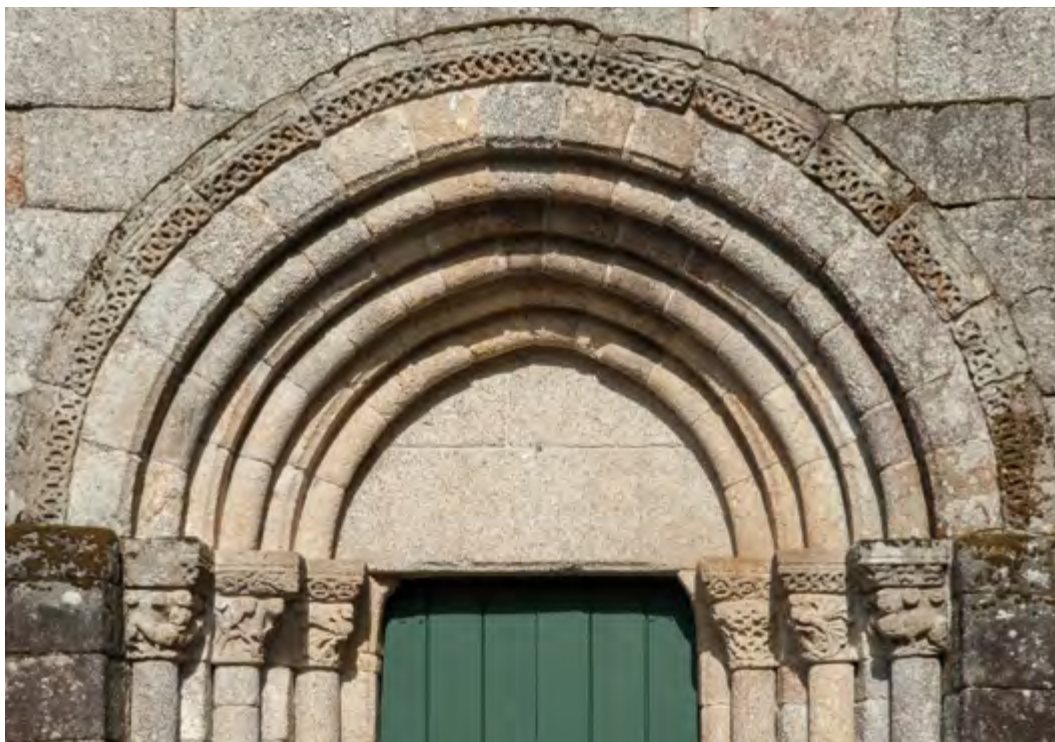
Igreja. Fachada ocidental. Portal.
