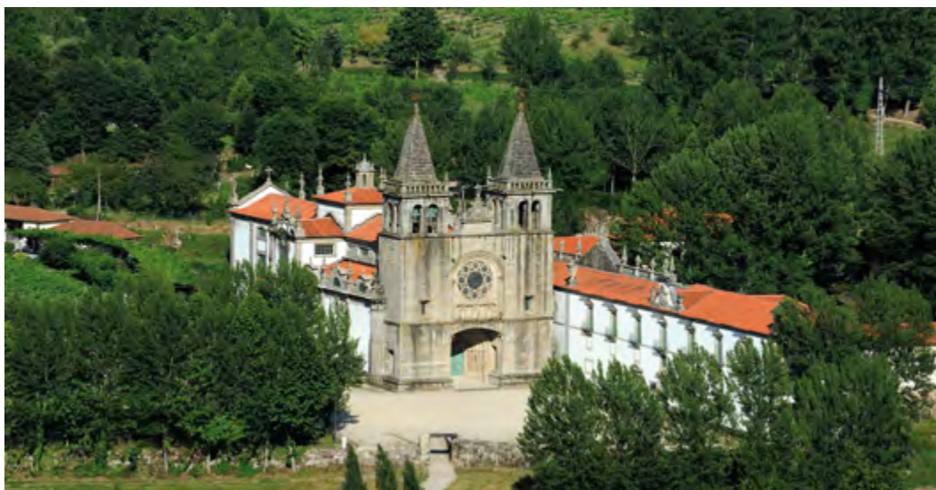
Mosteiro de Pombeiro (Felgueiras). Vista geral.
