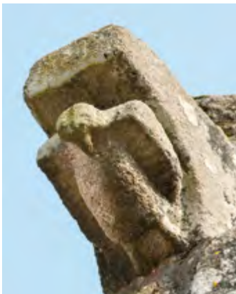
Fachada norte. Mísula.
