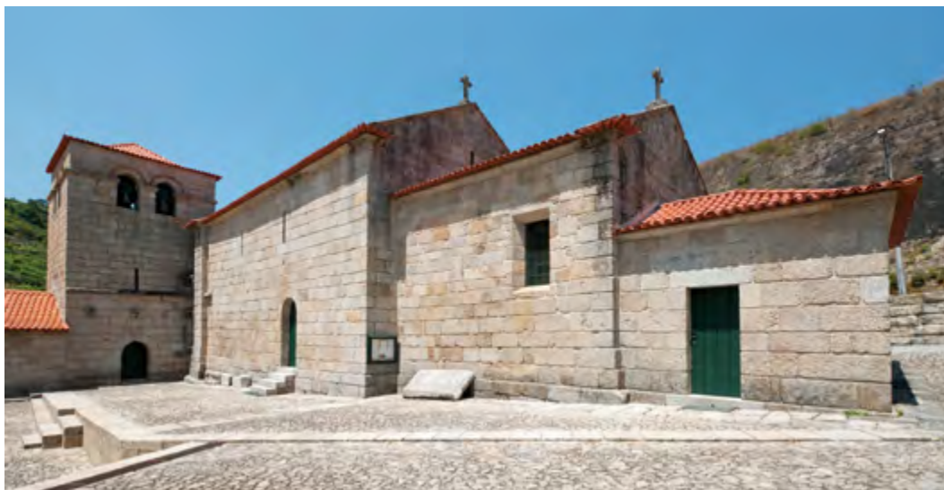
Igreja. Fachada sul.
