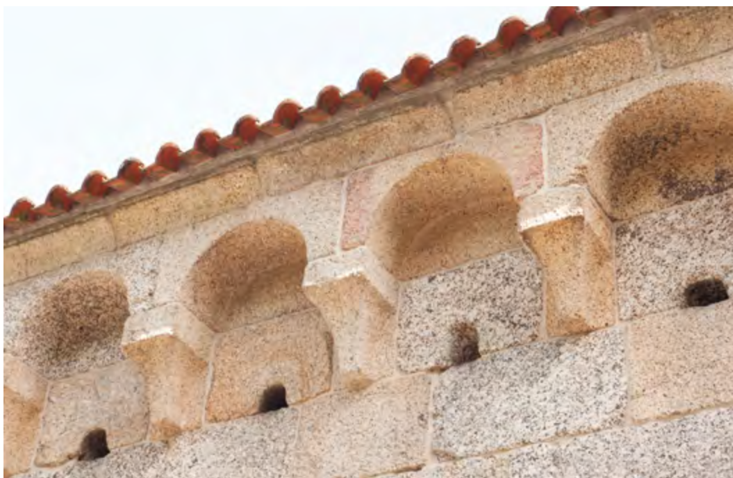
Fachada norte. Capela-mor. Cornija.
