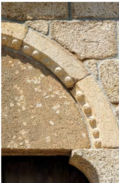
Fachada sul. Nave. Portal. Arquivolta. Pérolas.
