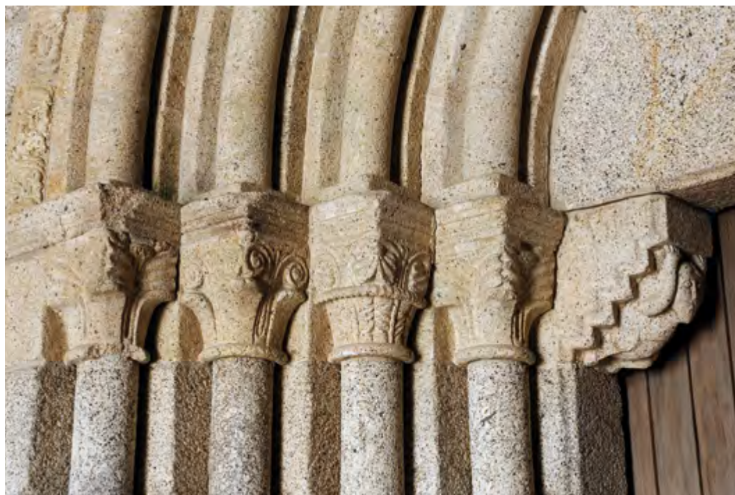
Igreja. Fachada ocidental. Portal. Capitéis e mísula.
