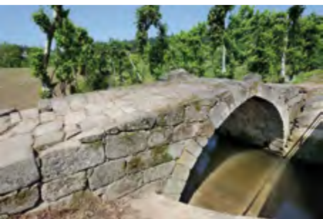
Ponte da Veiga (Lousada). Vista de montante.
