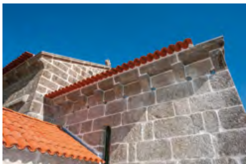
Fachada sul. Capela-mor. Cornija.
