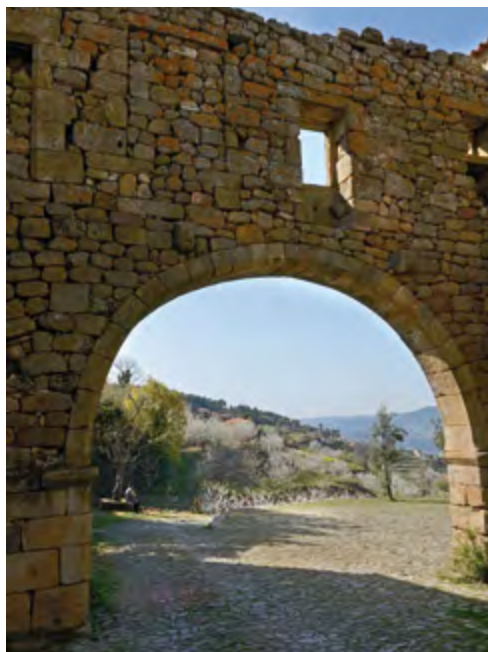
Passadiço existente sobre o arco que ligava a "Casa do Caseiro" ao "Conventinho", na atualidade.
