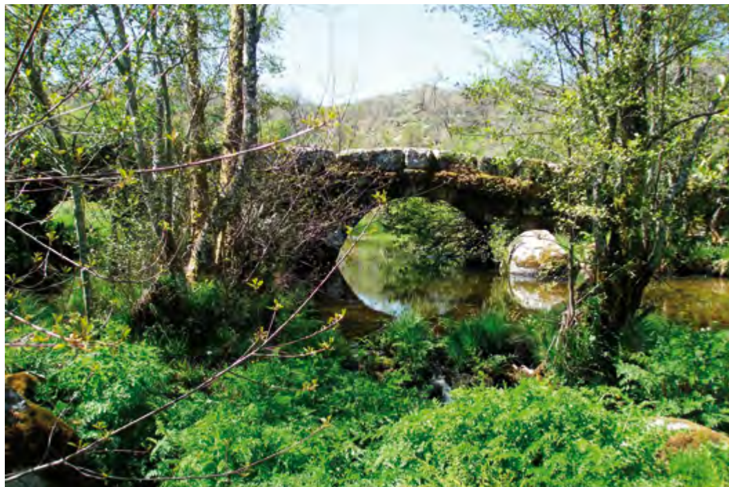
Vista de jusante.
