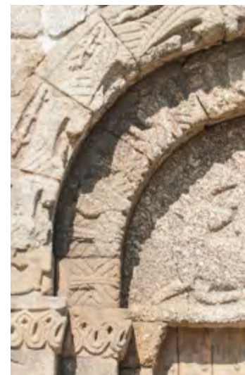
Mosteiro de Travanca (Amarante). Torre. Portal. Aduelas.
