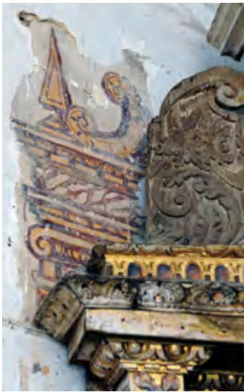
Nave. Parede norte antes das intervenções da Rota do Românico (2013). Pintura mural. Retábulo fingido .
