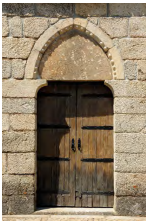
Fachada sul. Nave. Portal.
