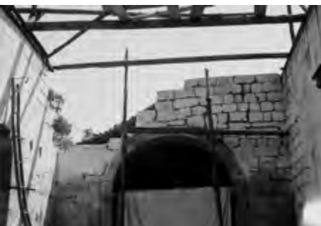
Obras de apeamento e reconstrução da empena do arco triunfal e de parte da parede norte. Fonte: arquivo IHRU.
