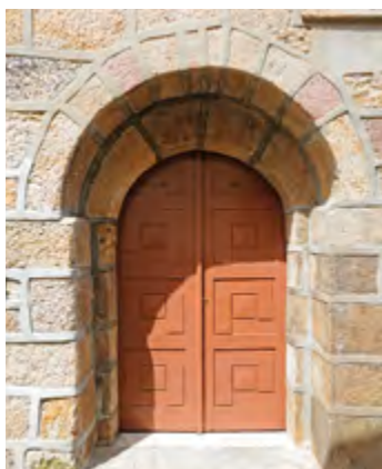
Fachada sul. Nave. Portal.
