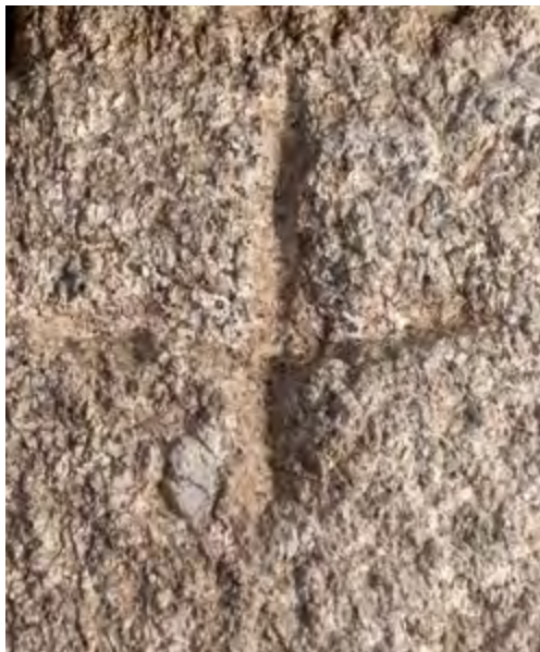
Igreja. Parede norte. Nave. Sigla.
