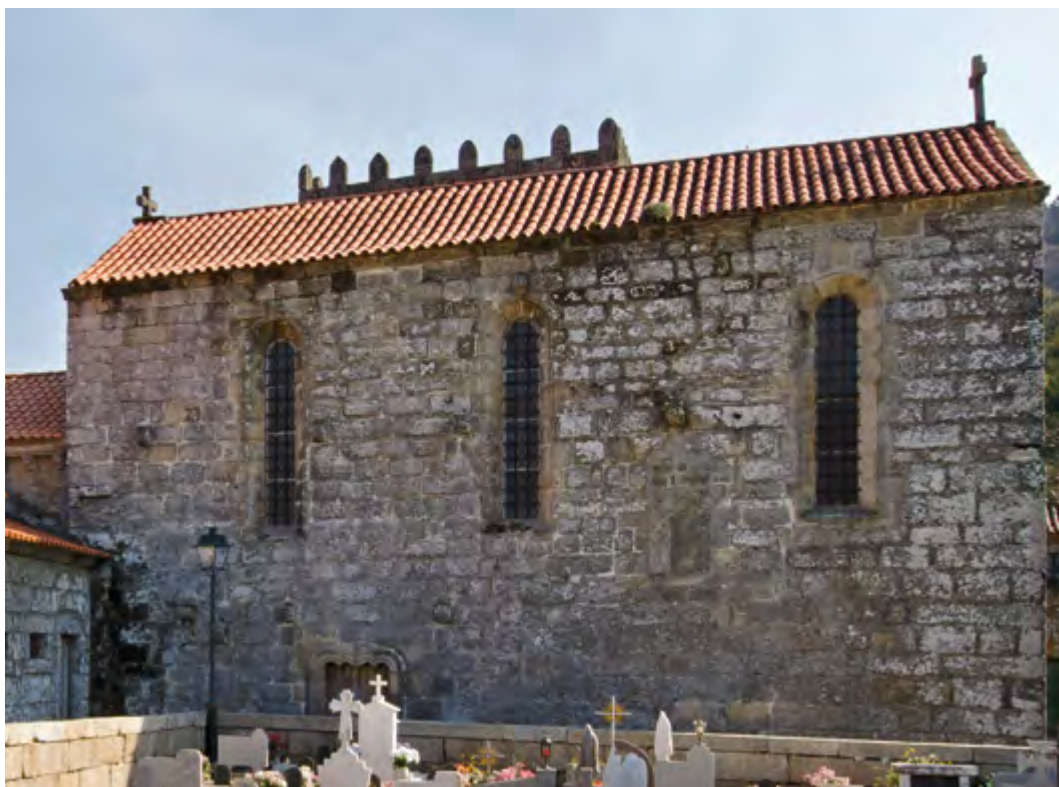
Igreja. Fachada norte.
