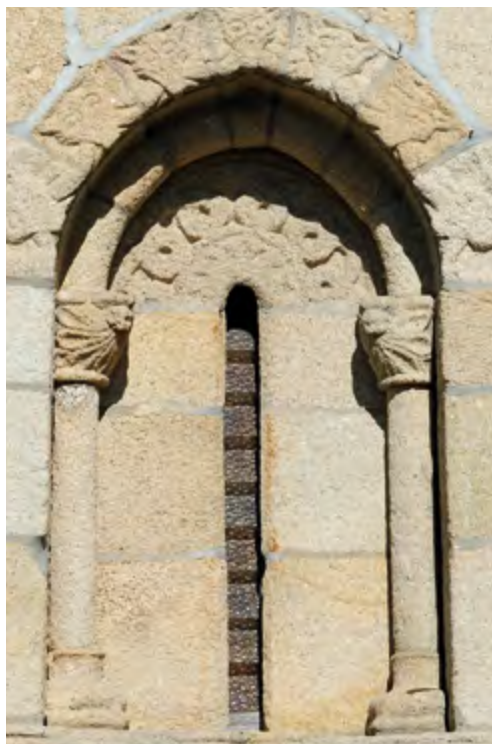
Fachada sul, Fresta.
