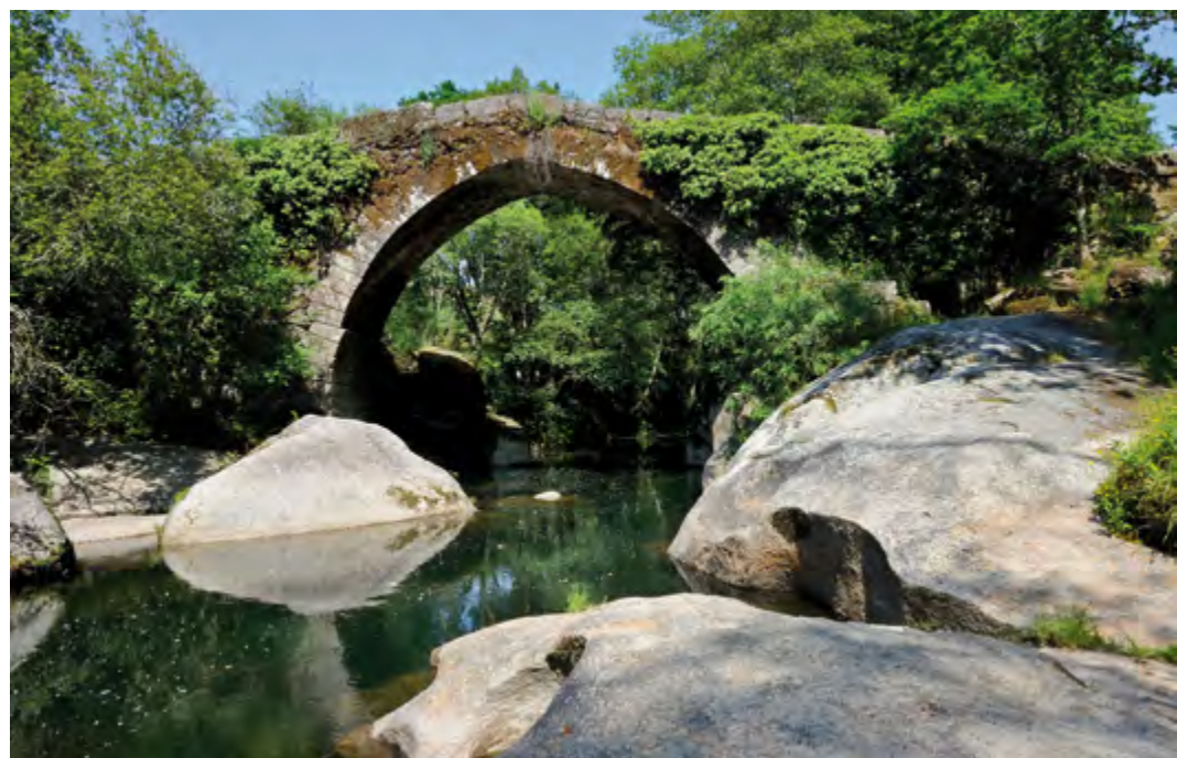
Vista de jusante.
