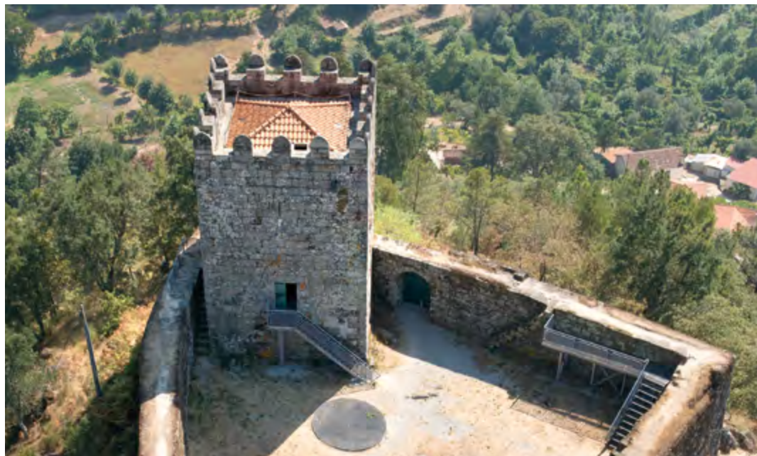
Torre de menagem. Vista aérea.
