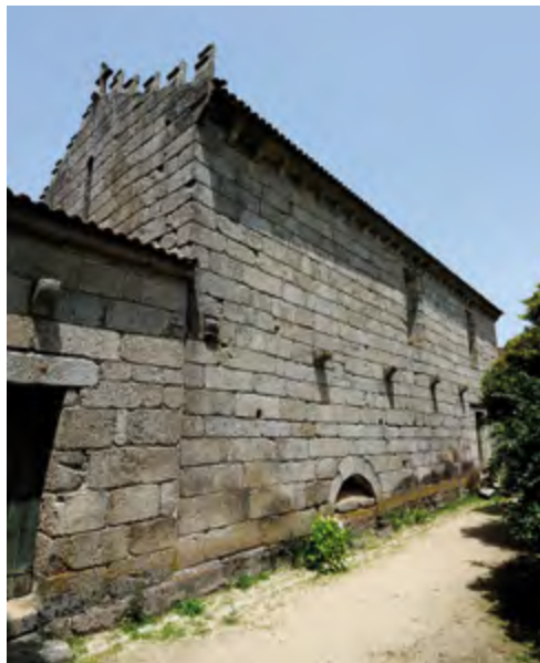
Igreja. Fachada sul.
