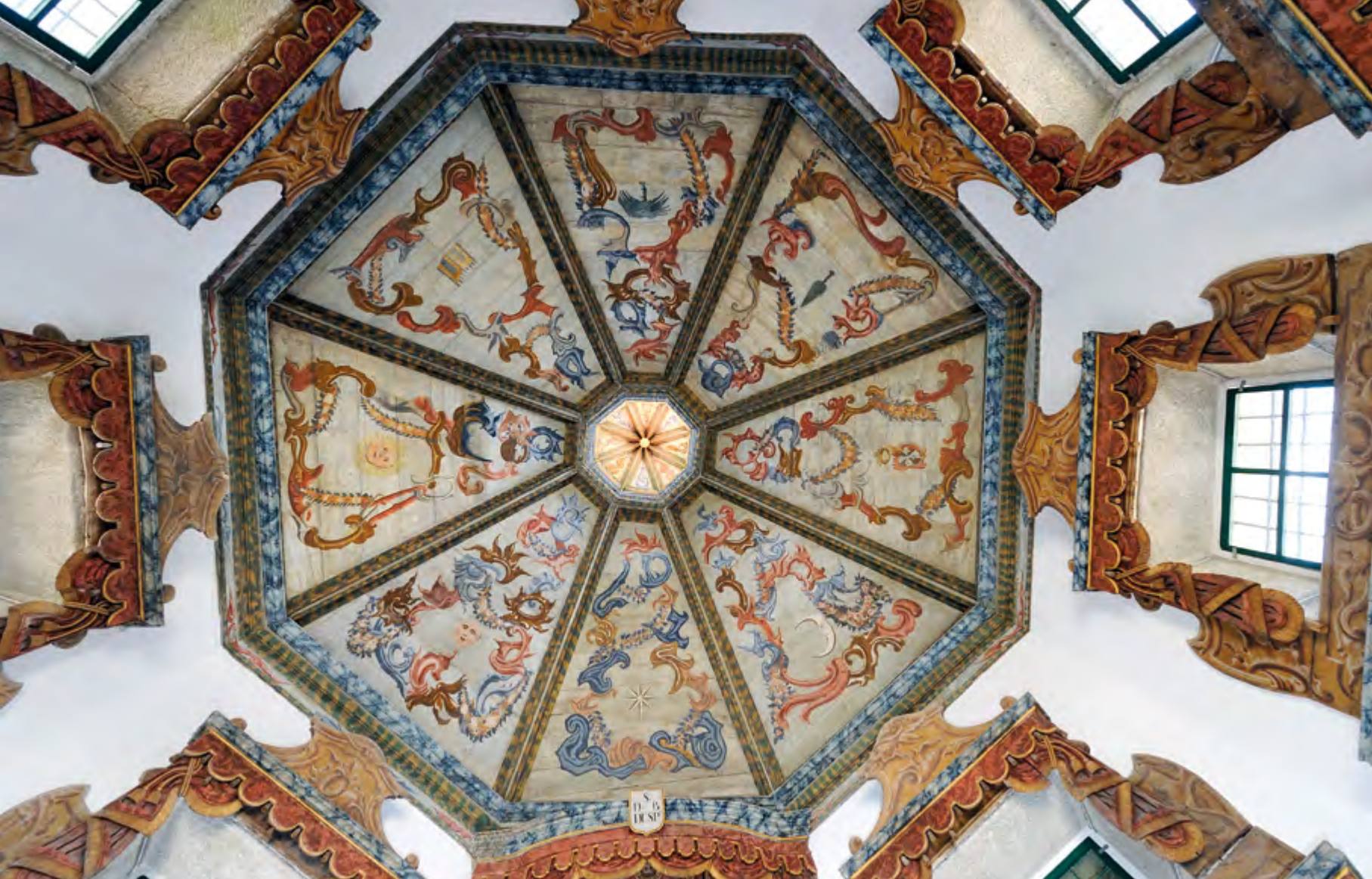
Capela do Senhor do Bom Despacho. Nave. Teto.
