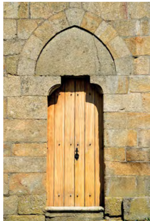
Fachada sul. Nave. Portal.
