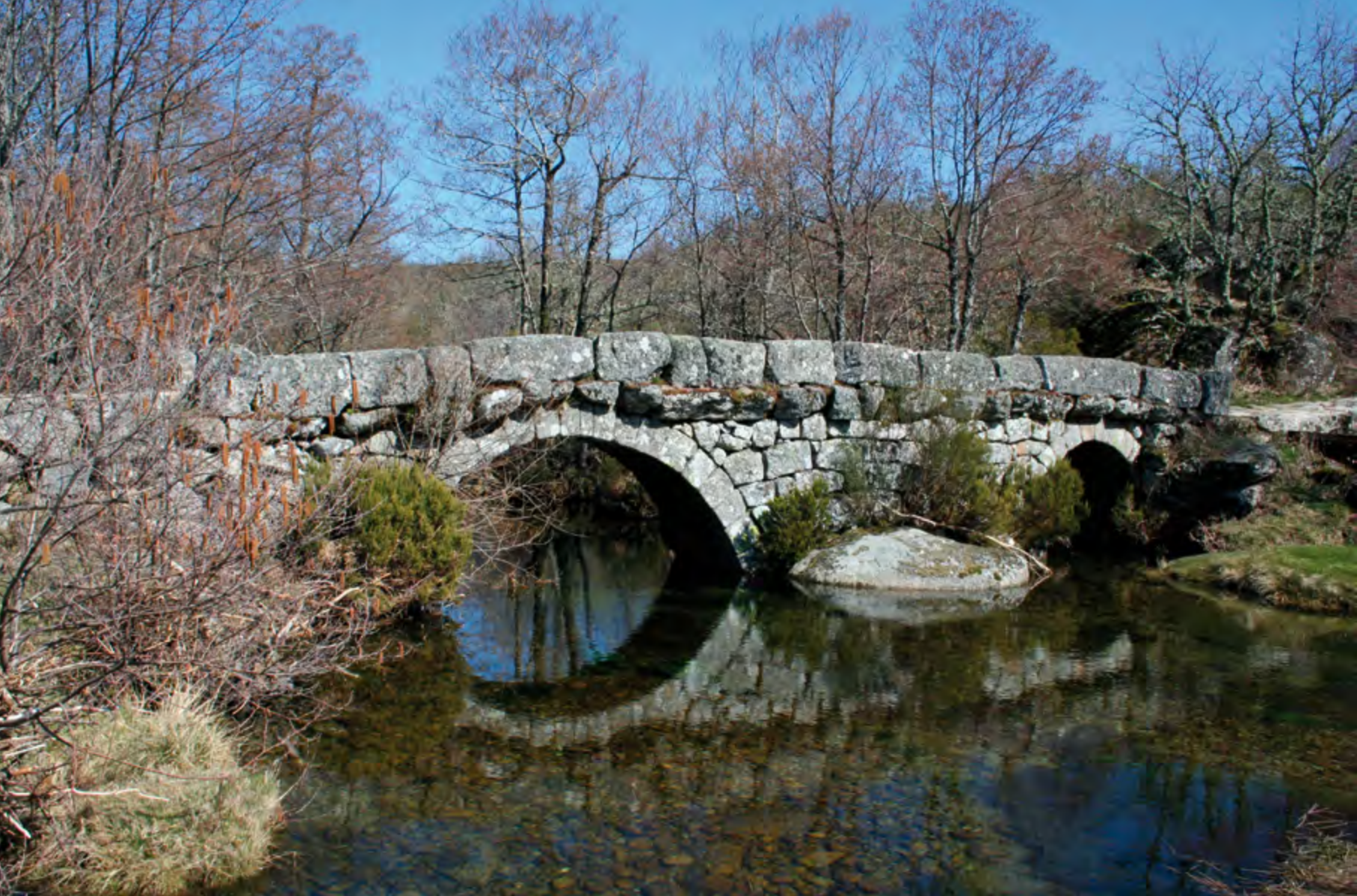
Vista de montante.
