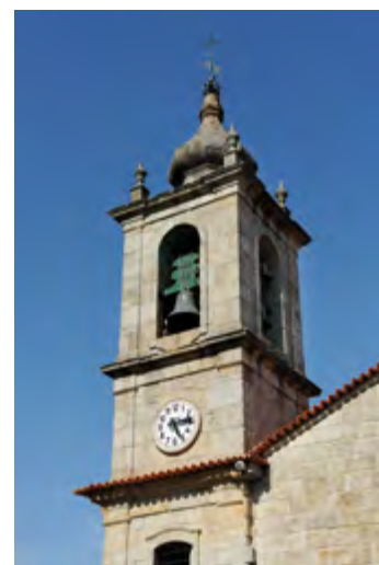
Fachada norte. Torre sineira.
