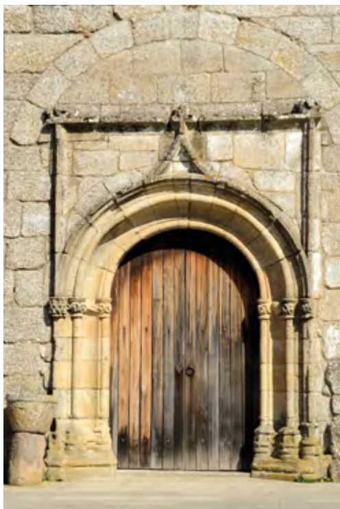
Igreja. Fachada ocidental. Portal.
