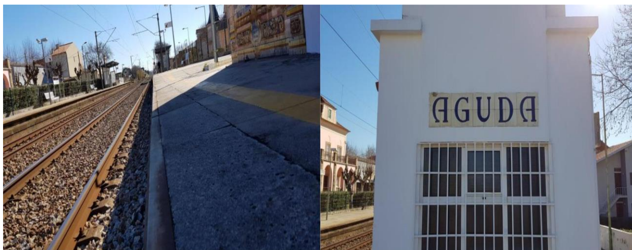
Figura 3 - Estação da Aguda.
