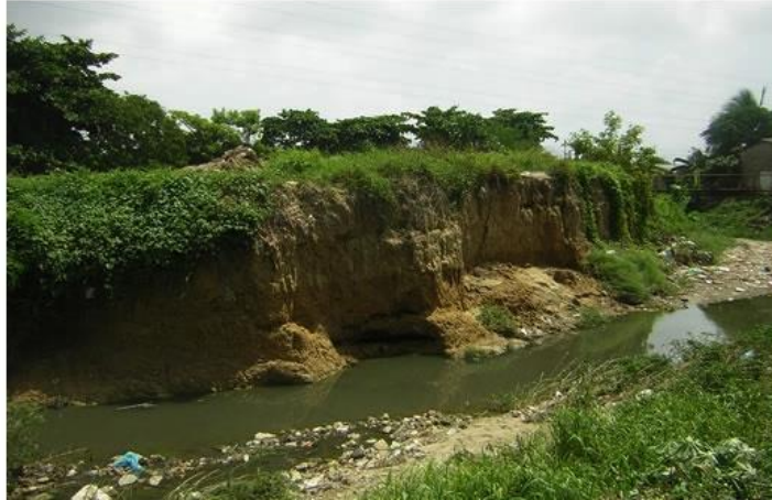
Figura 13: Zona de erosión en laderas del arroyo Don Juan. Fuente: http://www.barranquilla.gov.co/forohidrico/problematika.html
