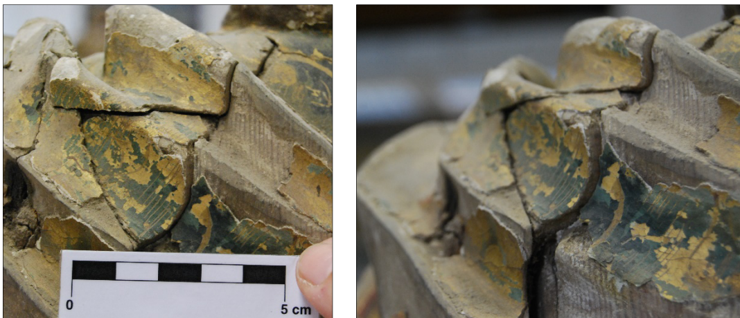
Figura 70 e 71. Pormenor do ombro esquerdo, onde se vê o bloco já totalmente solto e, por baixo deste, o bloco que se estende horizontalmente no interior da escultura e que se está a exercer contra um terceiro bloco do lado esquerdo contribuindo para o seu afastamento do corpo da escultura. A. P.
