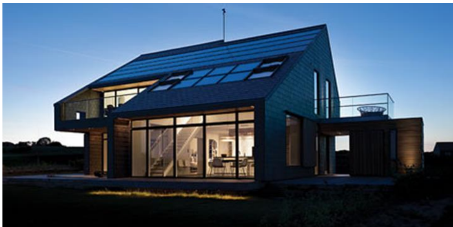
Figura 7 -Edifício Home for Life - Dinamarca [12].
