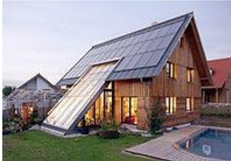
Figura 4 - Casa solar ativa Lorenz na Alemanha, 2003 [75].
