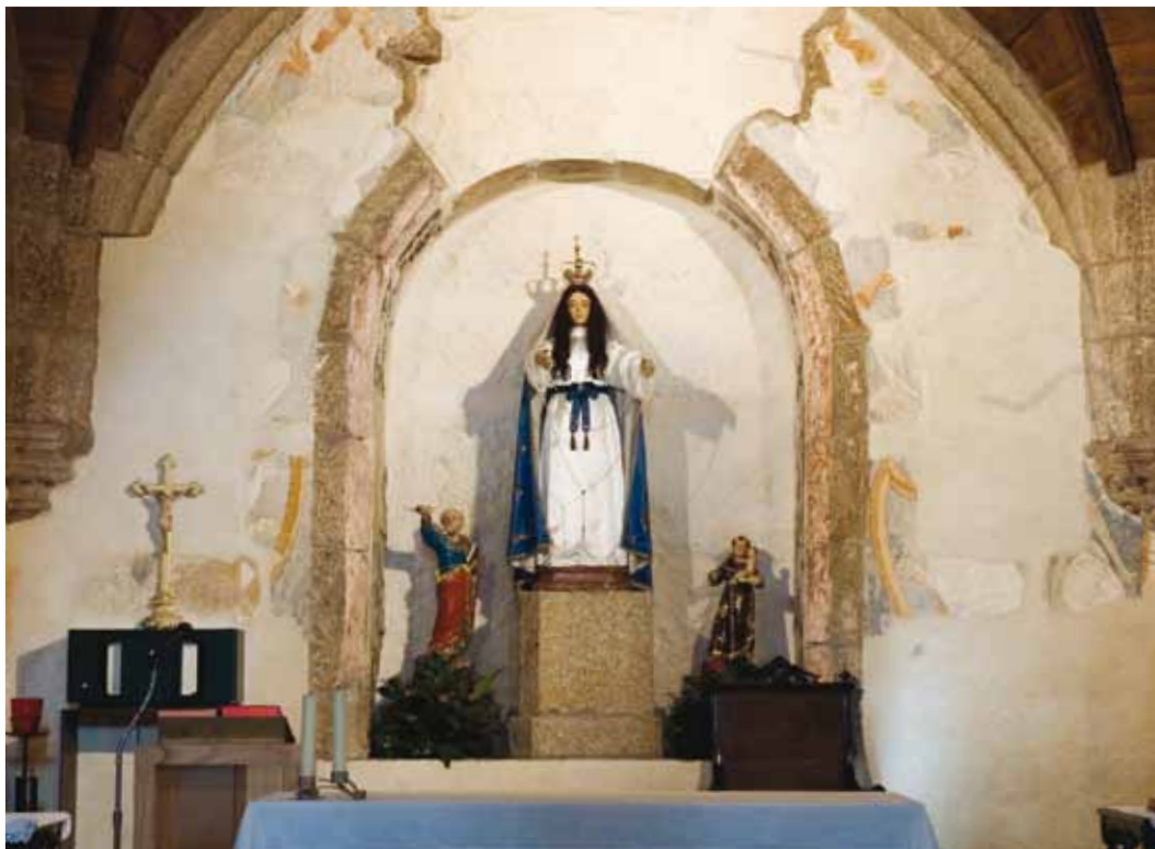
7. Cabeceira. Vestígios de pintura mural. Originalmente a pintura ladeava o nicho onde se encontra a imagem da padroeira. São visíveis as representações de anjos músicos.
