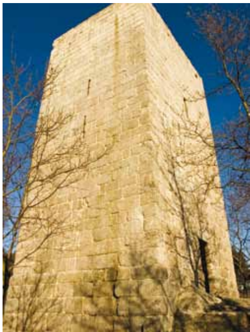
2. As paredes da Torre assentam directamente na rocha granítica.
