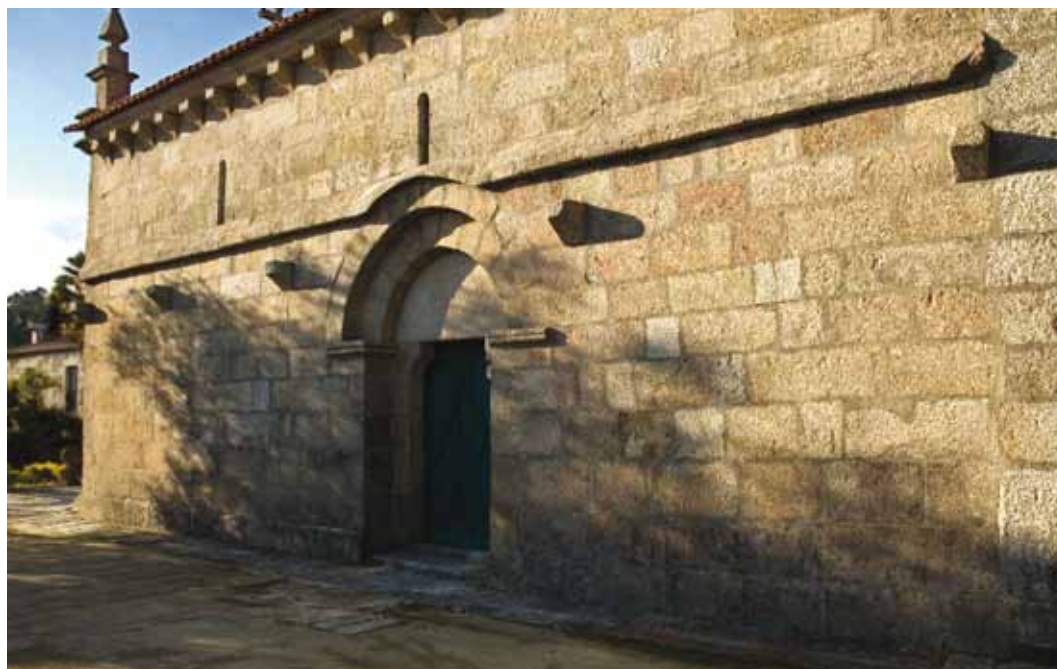
3. Fachada lateral sul. O lacrimal e as mísulas testemunham a existência de um alpendre.
