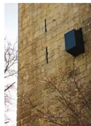
6. Vão de entrada, aberto posteriormente, ao qual se acedia pelo exterior através de uma escada de madeira.
