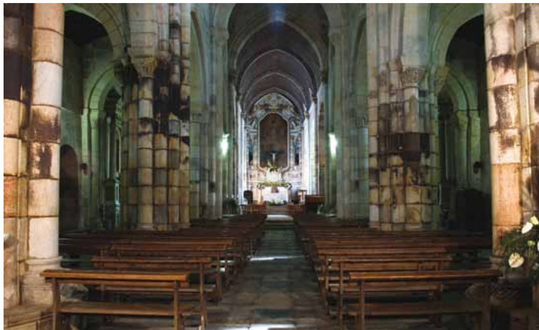
9. À primeira fase da construção da igreja correspondem o portal ocidental e o primeiro tramo das naves.
