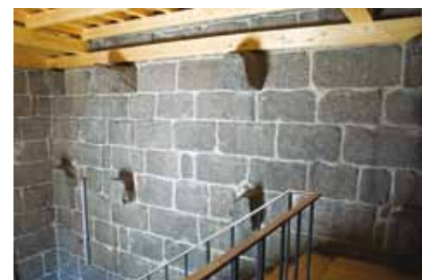
5. No interior da Torre subsistem mísulas salientes. Constituíam os apoios correspondentes aos vigamentos de quatro pisos.
