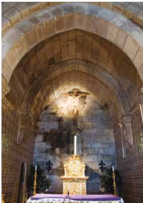
3. Cabeceira. As molduras dos arcos seguem modelos próprios da Época Gótica.
