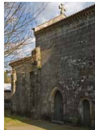
12. As frestas estreitas, que reforçam o carácter fechado dos muros, conferem ao Mosteiro de São Pedro de Cête um aspecto românico.
