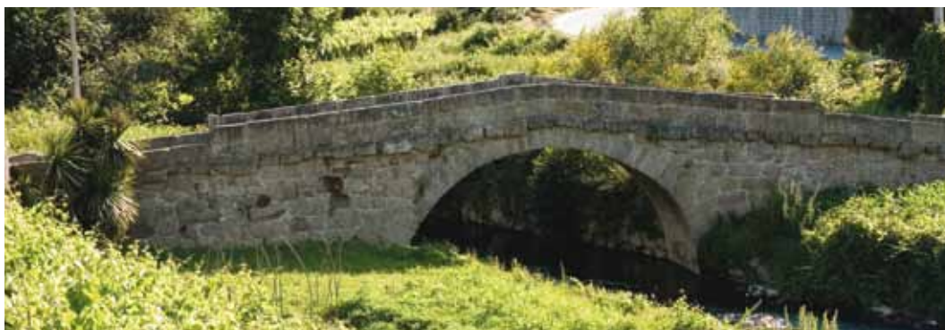
2. A Ponte de Espindo é constituída por um só arco apoiado em pilares que arrancam directamente das margens.
