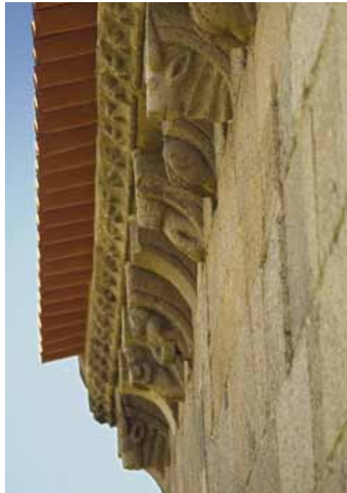
11. Cachorros da fachada norte.
