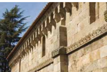
15. Fachada sul. Na cornija as arcaturas da nave lateral apoiam-se em cachorros. O friso que se estende ao longo do muro, à maneira das arquitecturas pré-românicas, é um dos aspectos mais característicos deste igreja.
