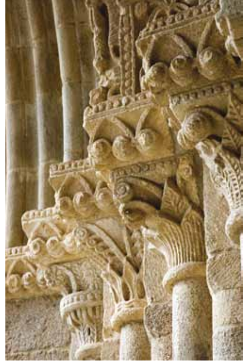
13. Portal ocidental. Capitéis.
