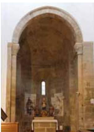
7. Absidiolo sul. As cabeceiras com abside e absidiolos escalonados, de planta semicircular, são habituais nos programas das igrejas de três naves, do Entre-Douro-e-Minho.
