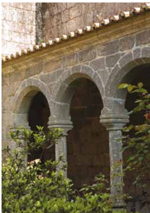
18. Por norma, embora haja muitas excepções, o claustro e os outros aposentos monásticos eram construídos a sul da igreja, por ser a zona mais quente, voltada ao sol.
