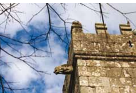
16. Coroamento da torre e gárgula.
