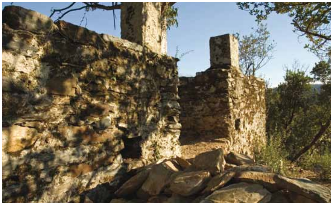
3. A base da Torre testemunha uma estrutura de planta quadrangular.
