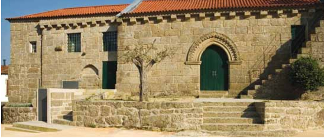
5. Fachada sul. O portal desta fachada apresenta a mesma solução decorativa que o arco triunfal, do interior da Igreja. A cabeceira foi ampliada em comprimento e em altura, posteriormente à edificação original.
