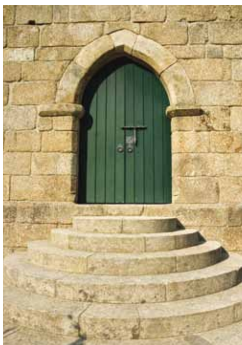
3. Portal ocidental. A ausência de colunas e de tímpano aponta para uma cronologia tardia, no âmbito do românico de resistência .
