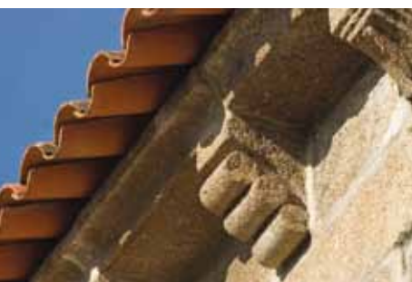
5. Fachada sul. Cachorros.
