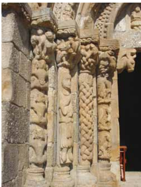
7. Igreja de São Salvador de Bravães (Ponte da Barca). Detalhe do portal ocidental.
