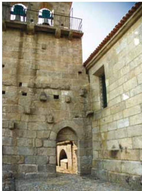
3. Cabeceira reconstruída na Época Moderna, sineira e arcossólio junto ao qual está gravada a inscrição Era M o CC o +. (ano de 1162).
