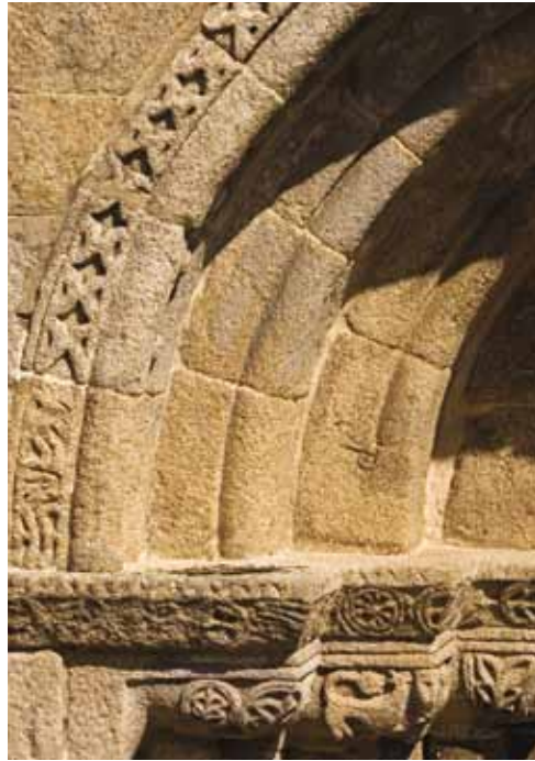
5. Arquivoltas e capitéis do portal ocidental que mostram o talhe a bisel, próprio do românico rural do Vale do Sousa.
