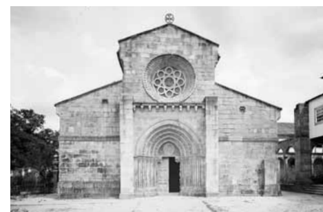
32. Fachada ocidental depois da intervenção da DGEMN.
