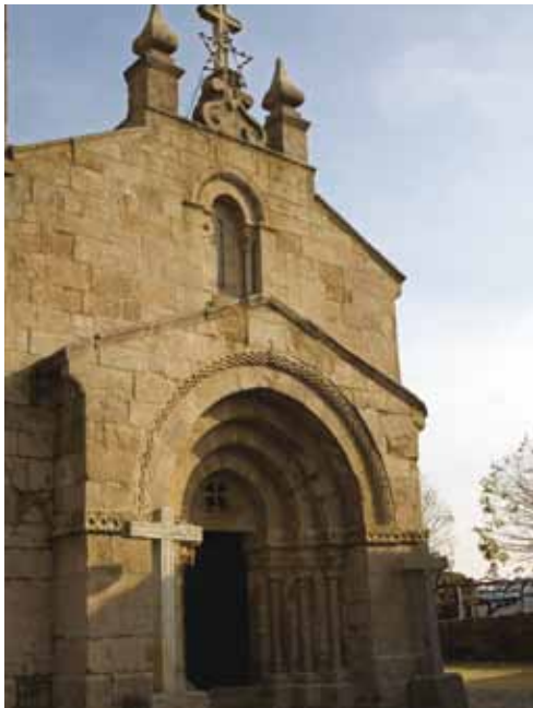
6. Fachada ocidental. O portal, inserido em estrutura pétreo, tem um alçado semelhante aos portais das Igrejas de São Vicente de Sousa e de Santa Maria de Airães, também do concelho de Felgueiras.
