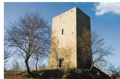
23. Consagrando antigas senhorias, as torres constituem um meio muito expressivo da forma de ocupar o território. Torre de Vilar.
