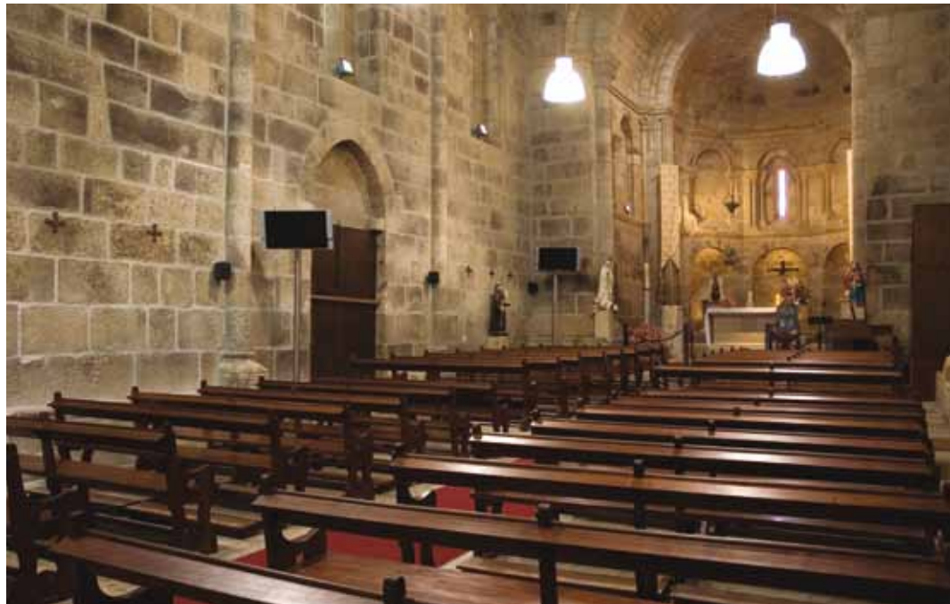
12. A nave da igreja recebeu colunas adossadas aos muros, embora seja coberta de madeira. A razão da existência das colunas que, exteriormente correspondem a contrafortes, está relacionada com a elevada altura da nave.
