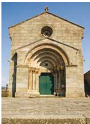
4. Fachada ocidental. O portal está inserido em estrutura pentagonal saliente à fachada, solução habitual nesta região, como demonstram os portais das Igrejas de Santa Maria de Airães e do Salvador de Unhão, ambas no concelho de Felgueiras.
