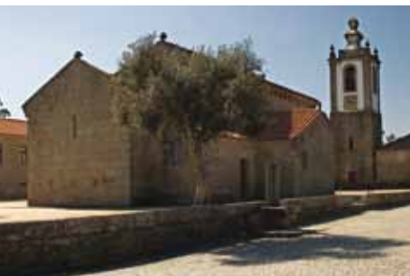
1. Formada por uma nave única e por uma cabeceira rectangular, a Igreja do Salvador de Cabeça Santa corresponde ao tipo mais comum dos templos construídos em Portugal, na Época Românica.
