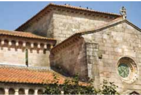
14. A parcela superior do transepto e a torre sobre o cruzeiro correspondem à última fase da construção.
