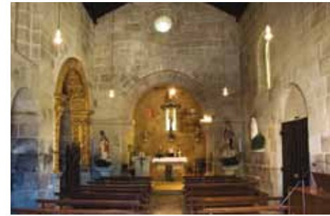
3. Tanto a nave como a cabeceira são cobertas de madeira, solução comum na arquitectura românica de Entre-Douro-e-Minho.
