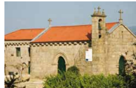
6. Fachadas sul e ocidental.
