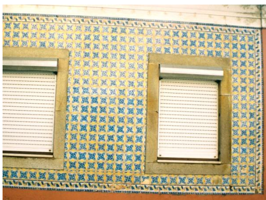
Aspecto geral de um dos lados da fachada
