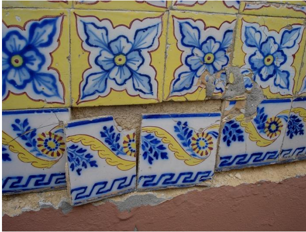
Durante a remoção dos azulejos
