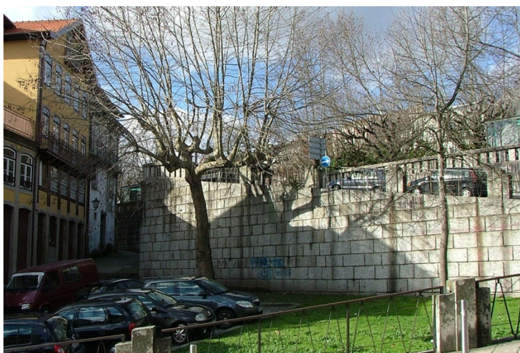
Fotografia 38 – muro de contenção e acesso à zona dos Couros.
