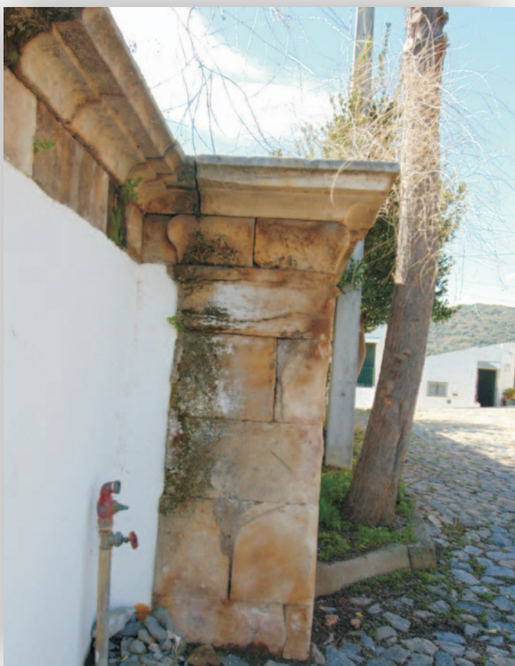
Fig. 22: Pormenor da antiga Igreja de Mós do Douro (actual cemitério) com cunhais e cornijas edificadas em aplito
