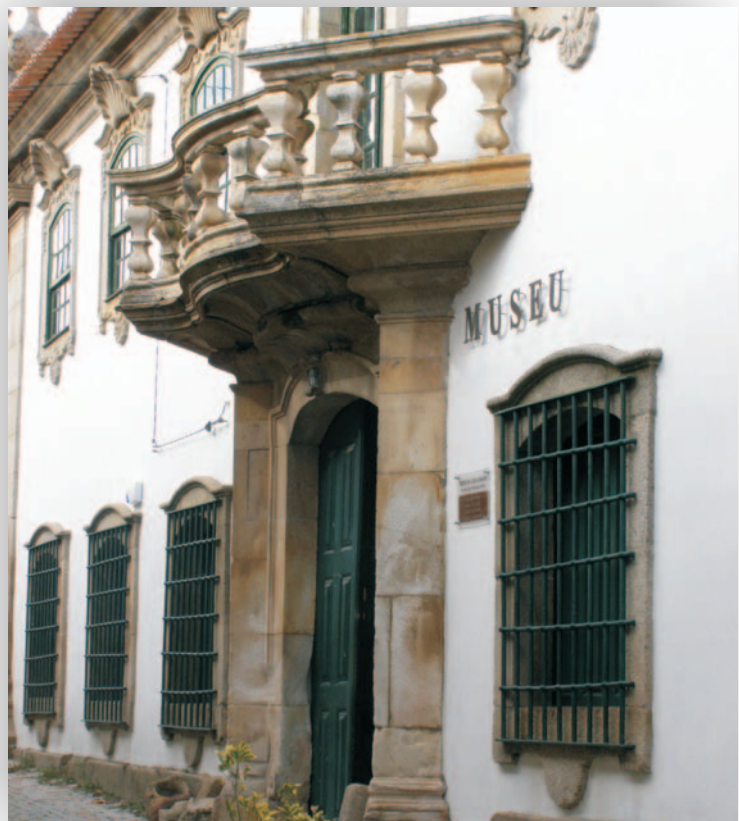
Fig. 18: Aplicação de apito na frontaria do solar da Casa Grande em Freixo de Numão
