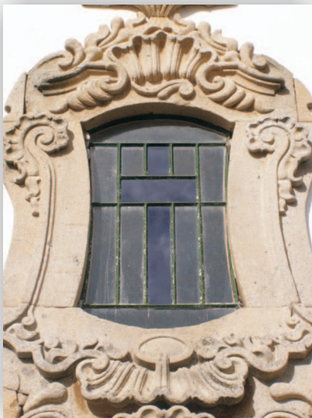
Fig. 20- Janelão da Capela da Casa Grande de Freixo de Numão - um exemplo de aplito aplicado na arte rococó
