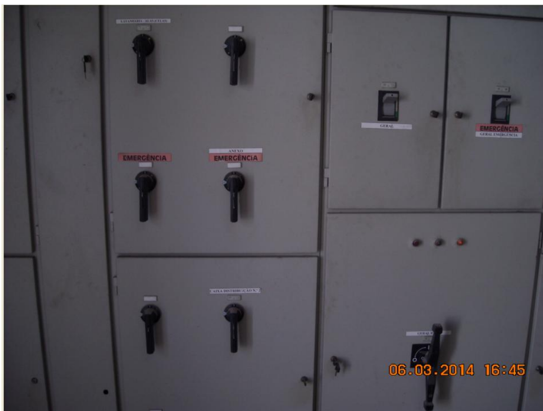
Figura 43: PT QGBT que recebe a corrente elétrica do transformador.
