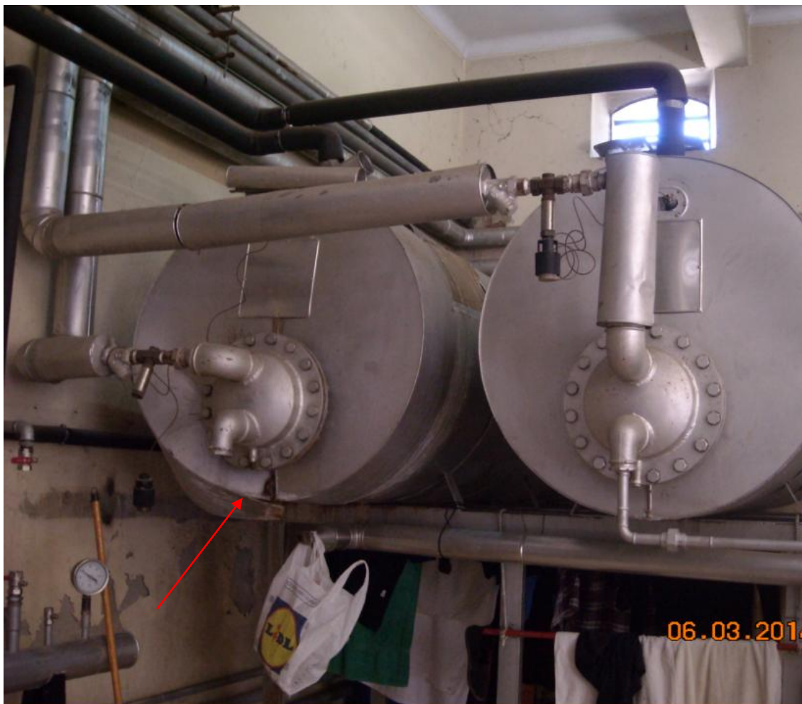
Figura 62: Depósitos Horizontais de Armazenamento de (AQS).
