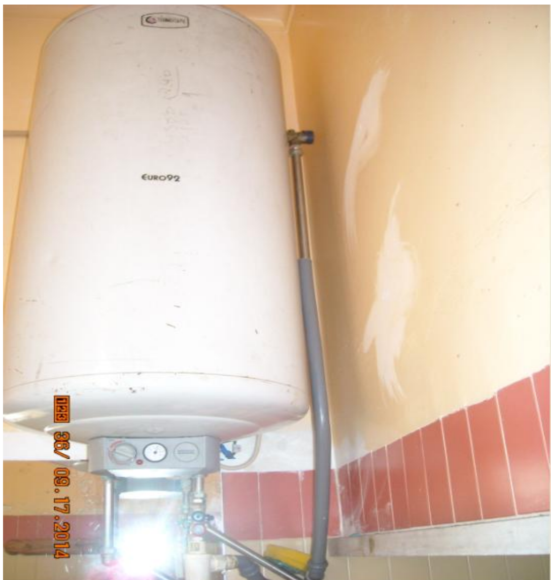
Figura 65: Termoacumulador. Elétrico
