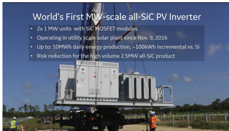
Figura 2.22 - Inversor de MW com SiCMOSFET's a ser instalado [58]
