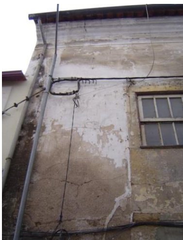
Figura 3.160 – Fachada do edifício
