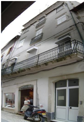
Figura 3.11 – Fachada exterior do edifício com NC4
