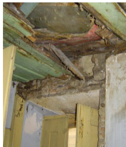
Figura 3.159 – Interior do edifício
