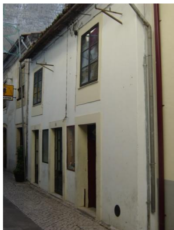
Figura 3.42 – Fachada do edifício
