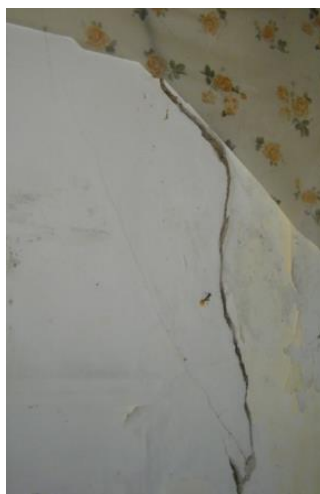
Figura 3.158 – Parede interior do edifício
