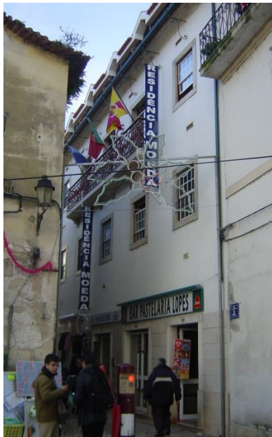
Figura 3.1 – Fachada do edifício com NC5
