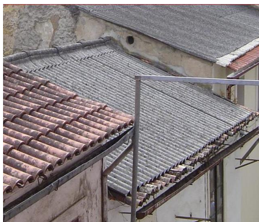
Figura 3.43 – Cobertura do edifício
