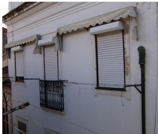
Figura 3.12 – Fachada exterior do edifício com NC4
