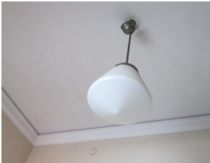
Figura 29- Iluminação presente no edifício de comando
