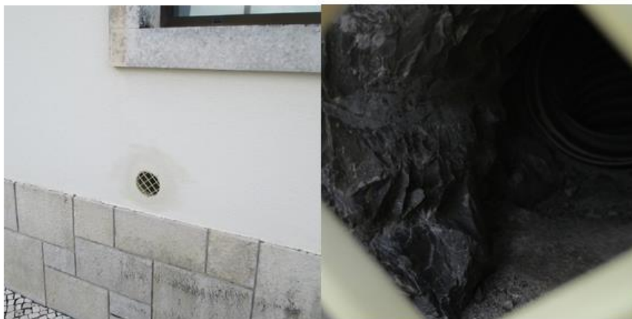
Figura 17 - Pormenor da abertura de ventilação onde se pode verificar que as paredes são de Basalto
