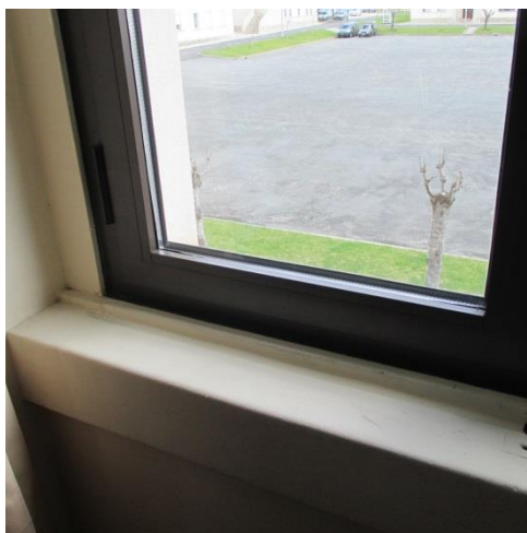
Figura 18 - Vidros duplos que se encontram atualmente no edifício
