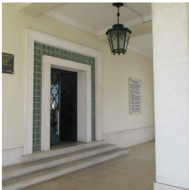
Figura 19 - Porta exterior do edifício
