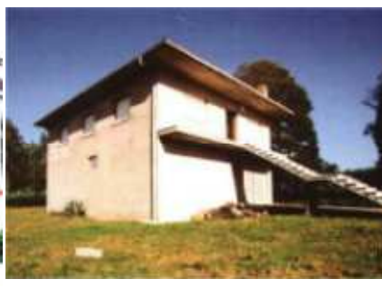
Fig.56. Escaleira na casa contemporánea.
