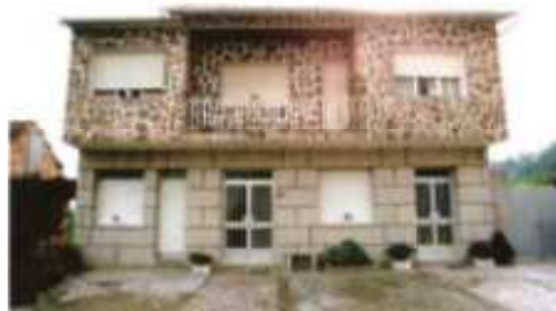
Fig.58.Duplicidade de entradas nunha casa en Cambados
