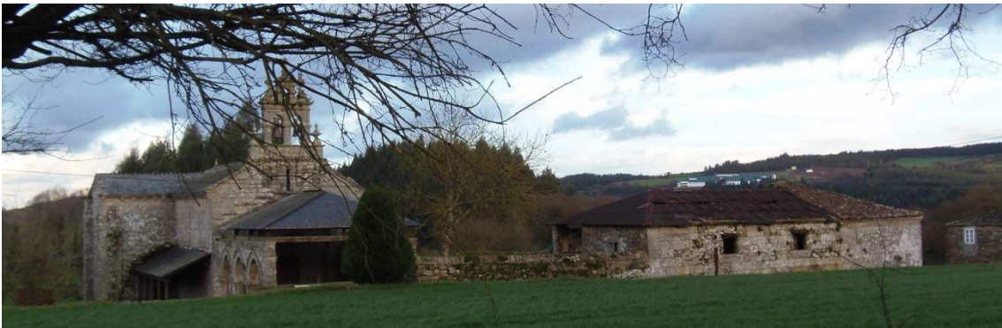
Fig. 12. Conxunto da Igrexa e restos do Mosteiro de Vilar de Donas Fonte: Autor
