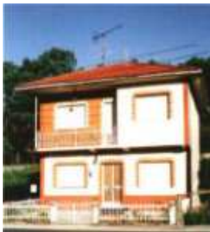
Fig.57.Acabamentos nunha casa en Boimorto.
