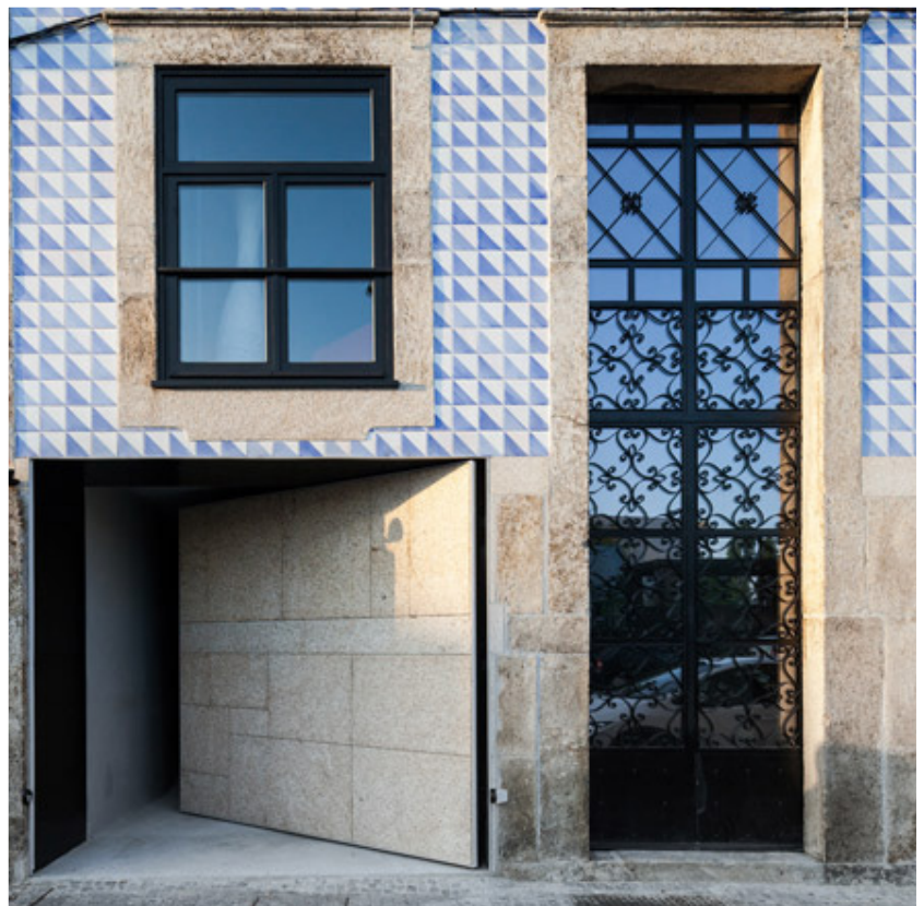
IMAGEM 102 Office building, OODA 2014
