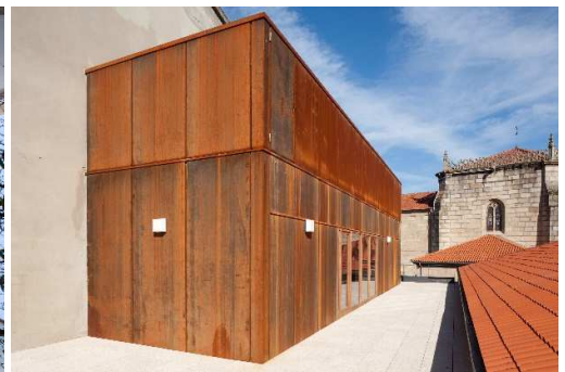
Fig. 6.2.23 Encuentro cubierta y terraza.
