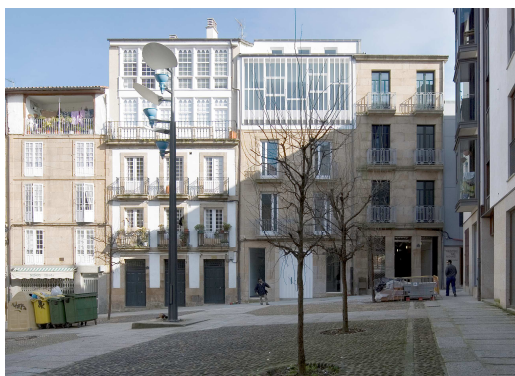
Fig. 6.7.9 Fachada Plaza de la Herrería.
