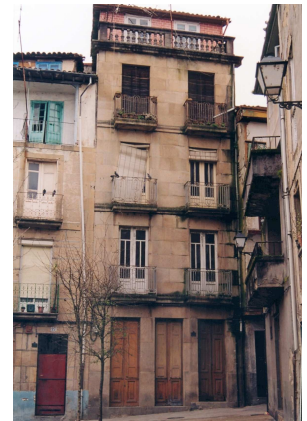
Fig. 6.6.5 Fachada C/ Cervantes.
