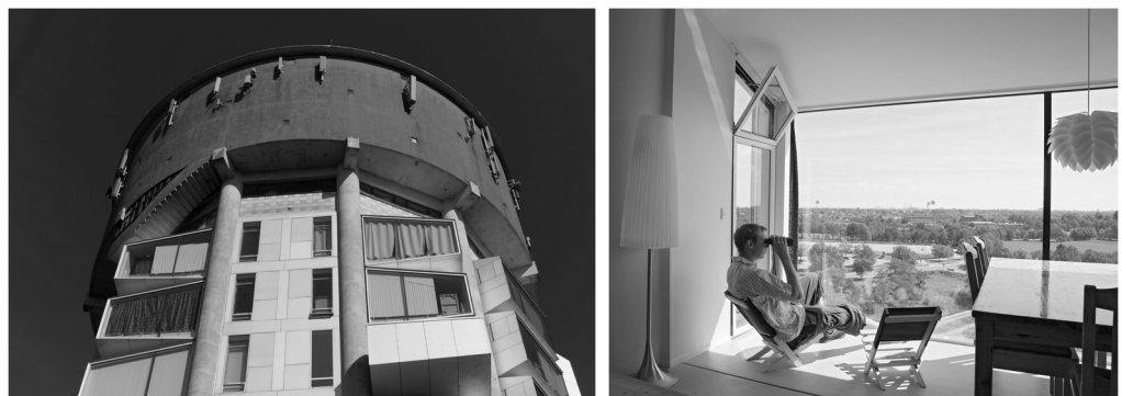
Fig. 1.8 y 1.9 Depósito de agua adaptado a alojamiento para estudiantes en Copenhague, Dinamarca.
