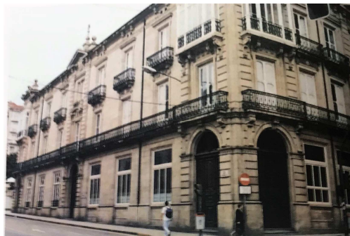
Fig. 6.5.5 Carpinterías antes de la intervención.
