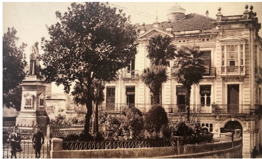
Fig. 6.5.3 Fachada Plaza de Eugenio Montes.
