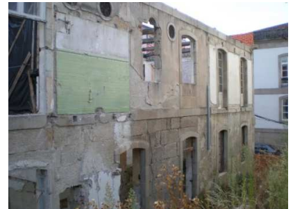
Fig. 6.2.7 - 8 Demolición de anexo en fachada posterior, previo elaboración proyecto.
