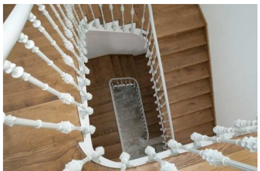
Fig. 6.2.25 Caja de escaleras.
