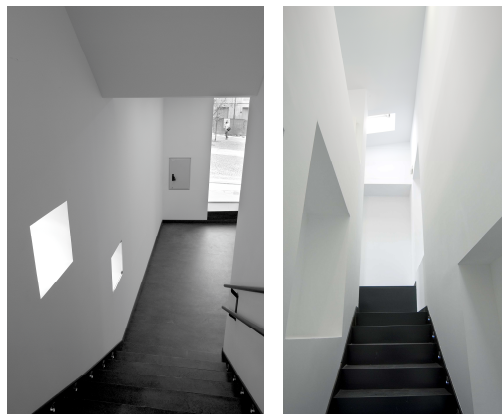
Fig. 6.7.15 - 16 Caja de las escaleras.
