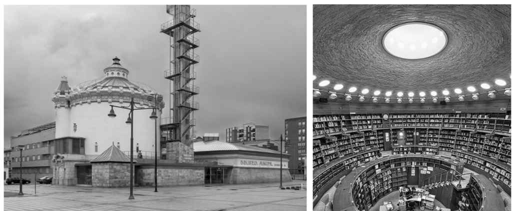
Fig. 1.10 y 1.11 Depósito de agua adaptado a biblioteca en Albacete, España.
