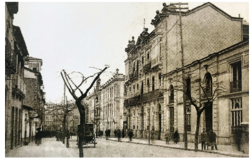
Fig. 6.5.4 Fachada C/ Progreso.
