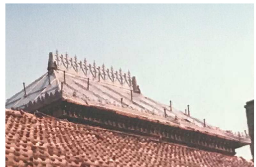
Fig. 6.5.6 Cubierta de teja y lucernario principal.
