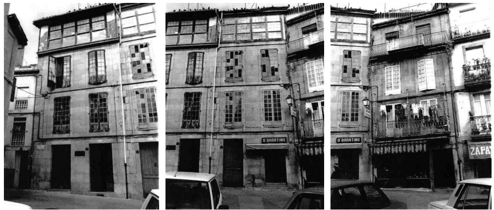
Fig. 6.3.3 - 5 Fachadas frontales nº12, 10 y 8.
