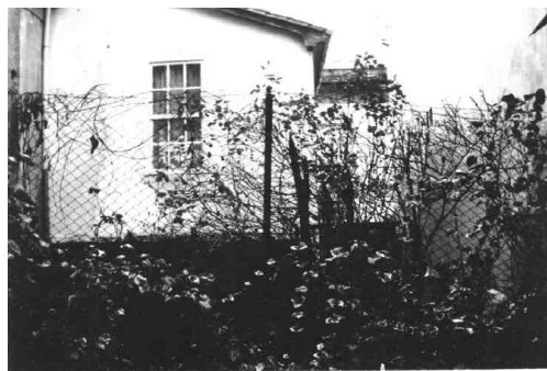
Fig. 6.2.5 Adición en Fachada posterior.
