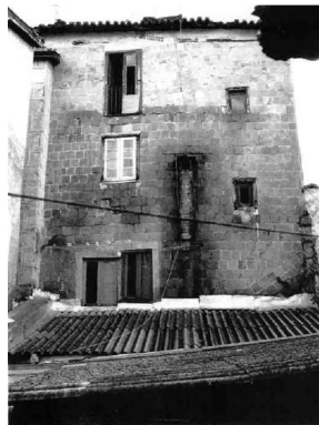
Fig. 6.6.6 Fachada Posterior C/ Colón.
