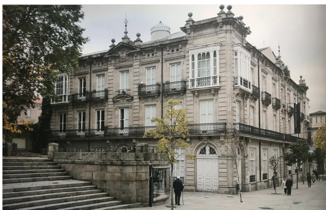
Fig. 6.5.23 Fachada Plaza de Eugenio Montes.
