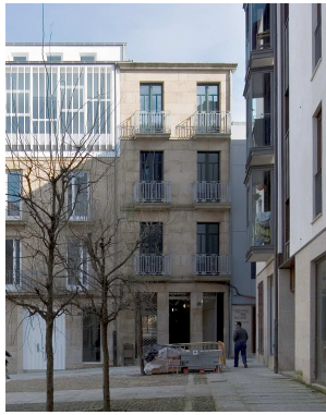
Fig. 6.6.10 Fachada C/ Cervantes.
