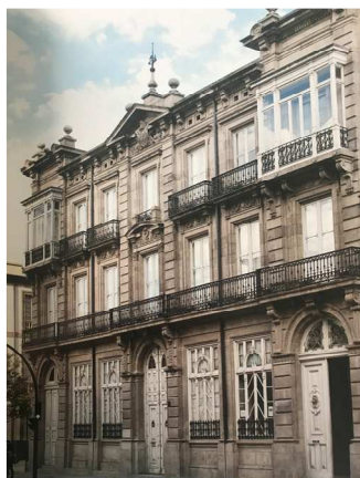
Fig. 6.5.22 Fachada C/ Progreso.
