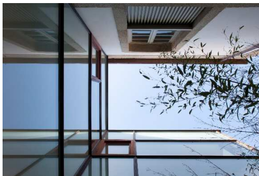
Fig. 6.2.21 Encuentro preexistencia y anexo.
