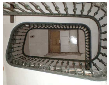
Fig. 6.2.10 - 11 Caja de escaleras.
