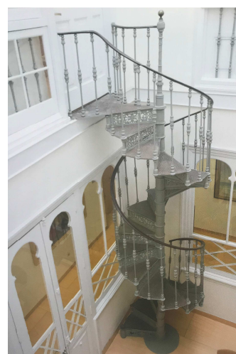
Fig. 6.5.26 Escalera de fundición.
