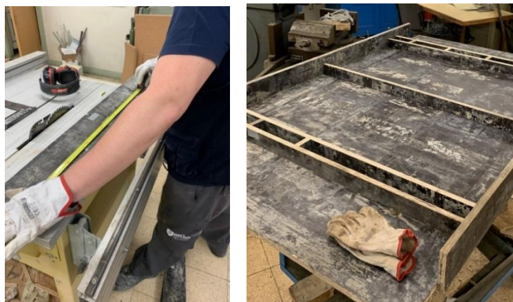
Figura 18 - Cofragens das pré-lajes e prismas.
