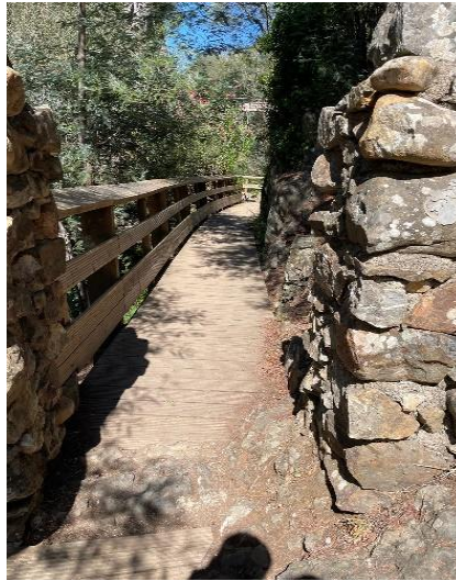
Anexo 19: Ponte Passadiço Penedo Furado. Fonte: Elaboração própria
