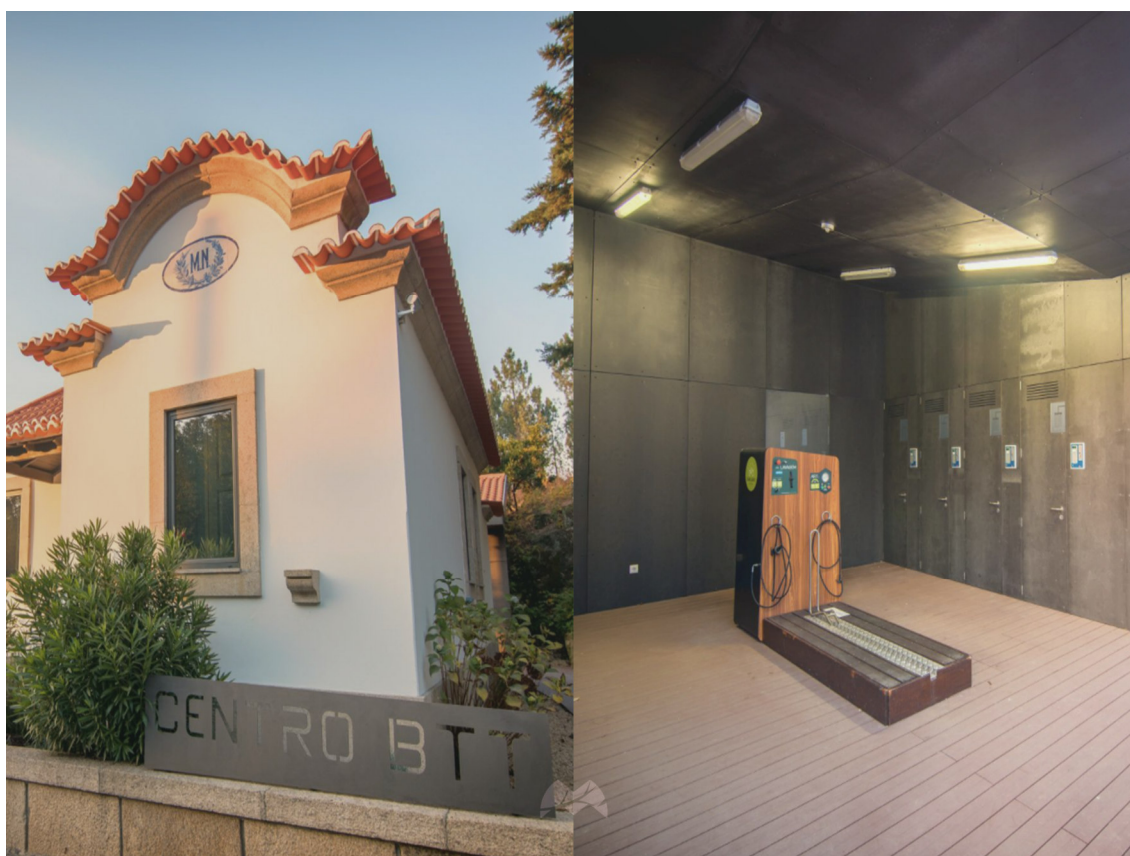
Figura 13 Centro de BTT
