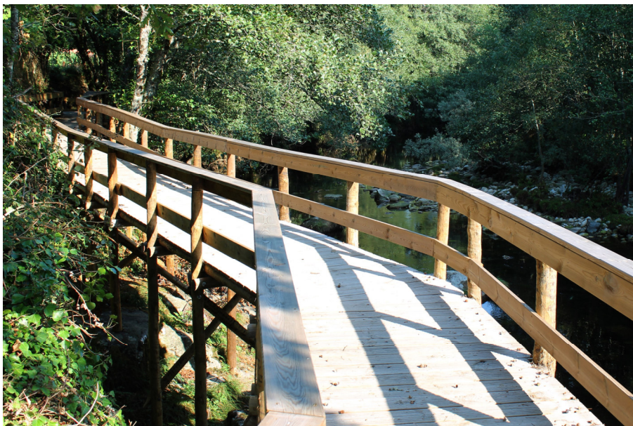
Figura 39 Passadiço Tipologia G3-G4-G5
