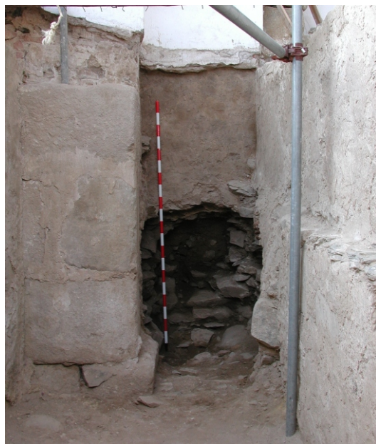
Fig. 5. Aparejo de grandes sillares de granit en la base del mihrāb de la mezquita de Mértola.
