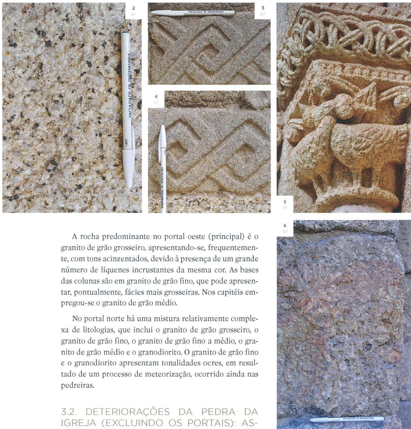
FIGURAS 2 A 6. Aspecto macroscópico das rochas graníticas aplicadas nos portais da Igreja e da Torre: a) granito de grão grosso; b) granito de grão fino; c) granito de grão fino a médio sobre bloco de granito de grão grosso; d) granito de grão médio; e) granodiorito (Begonha e Novais, 2011, p. 2).
