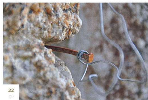
FIGURAS 16 A 22. Aspecto macroscópico das deteriorações da pedra dos portais oeste e norte Igreja: a), b), c) e d) desagregação granular (portal oeste); e) e f) líquenes (portal oeste); g) elementos metálicos não estruturais e não funcionais (prego com arame) (portal oeste) (Begonha e Novais, 2011, p. 12).
