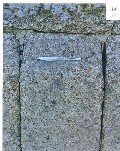
FIGURAS 8 A 14. Aspecto macroscópico das deteriorações da pedra das fachadas da Igreja: a) líquenes (fachada norte); b) musgos (fachada norte); c) planta superior (fachada oeste); d) algas (fachada oeste); e) desagregação granular (fachada oeste); f) placa (fachada norte); g) juntas abertas (fachada oeste) (Begonha e Novais, 2011, p. 6).
