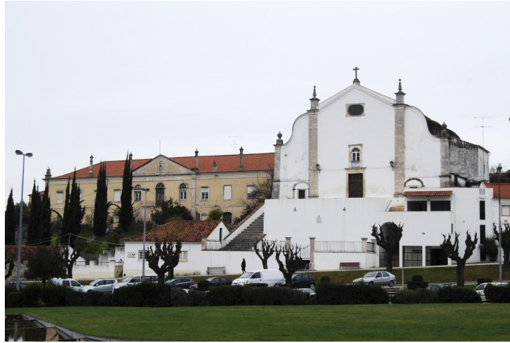
Figura 7 | Alçado Sudeste do antigo Convento do Carmo antes da intervenção (Fonte: CMTN)
