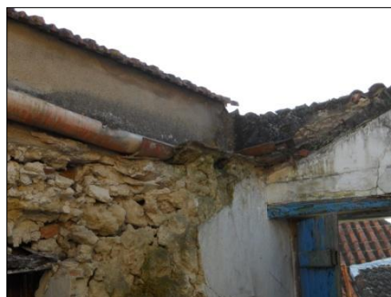
Figura 22 | Revestimentos da cobertura [Esquerda – telha Marselha ; Direita – telha de canudo ] (Inês Jerónimo, 2011)
