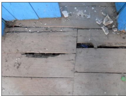
Figura 34 | Estado de conservação do soalho de madeira [Piso 1] (Inês Jerónimo, 2011)
