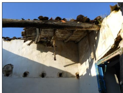
Figura 21 | Estrutura da cobertura [Área desmoronada] ( Inês Jerónimo, 2011 )
