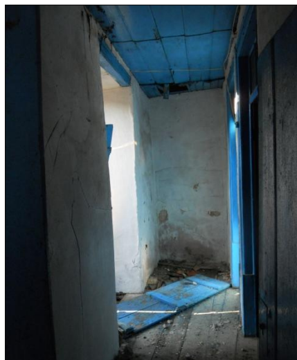
Figura 11 | Vista geral do corredor [Piso 1] ( Inês Jerónimo, 2011 )
