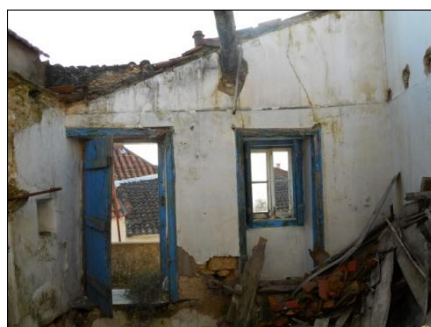
Figura 13 | Vista interior dos vãos do compartimento em ruína [Piso 1] (Inês Jerónimo, 2011)
