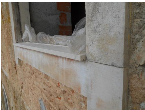
Figura 11 | Exemplo de capeamento em mármore – Alçado Sudeste, SO17
