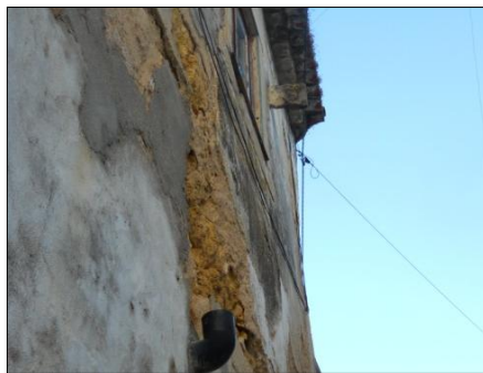
Figura 37 | Deformação de paramento exterior para fora do plano [Travessa do Forno] (Inês Jerónimo, 2011)
