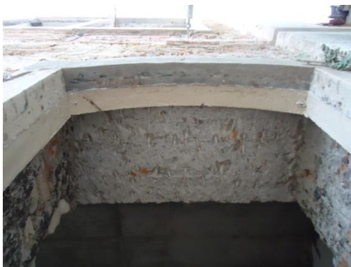
Figura 15 | Verga em betão rebocado – Alçado Sudeste, SE14
