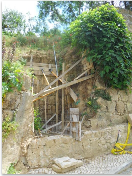
Figuras 57 e 58 | Percurso pedonal – A | Fundações do muro de betão [Junho de 2012] ( Inês Jerónimo, 2012 )
