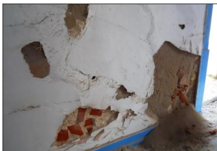
Figura 36 | Estado de conservação do paramento de entrada [Piso 1] (Inês Jerónimo, 2011)
