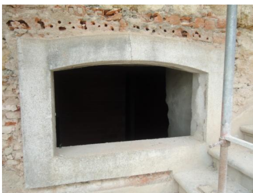
Figura 14 | Guarnecimento em betão rebocado – Alçado Sudeste, SE06
