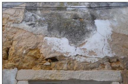
Figura 38 | Pormenor da deformação de paramento exterior para fora do plano [Travessa do Forno] (Inês Jerónimo, 2011)
