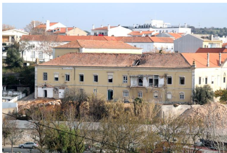
Figura 9 | Alçado Sudoeste do antigo Convento do Carmo após a demolição dos edifícios anexos adossados (Fonte: CMTN – Janeiro de 2012)
