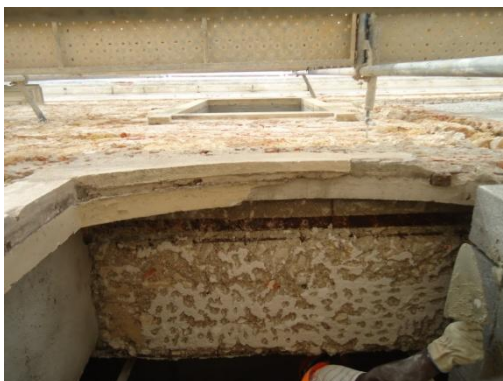
Figura 19 | Verga em betão rebocado – Alçado Sudoeste, SO07
