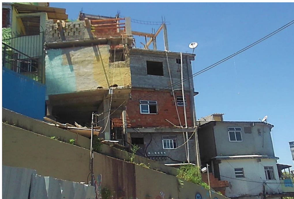
Fig. 5.75 Fotografía de tipología constructiva que a su vez ayuda a reforzar la idea de espacio-movimiento a través de un barraco de tres alturas -cada una en una etapa distinta de construcción- y los comienzos de una cuarta planta.
