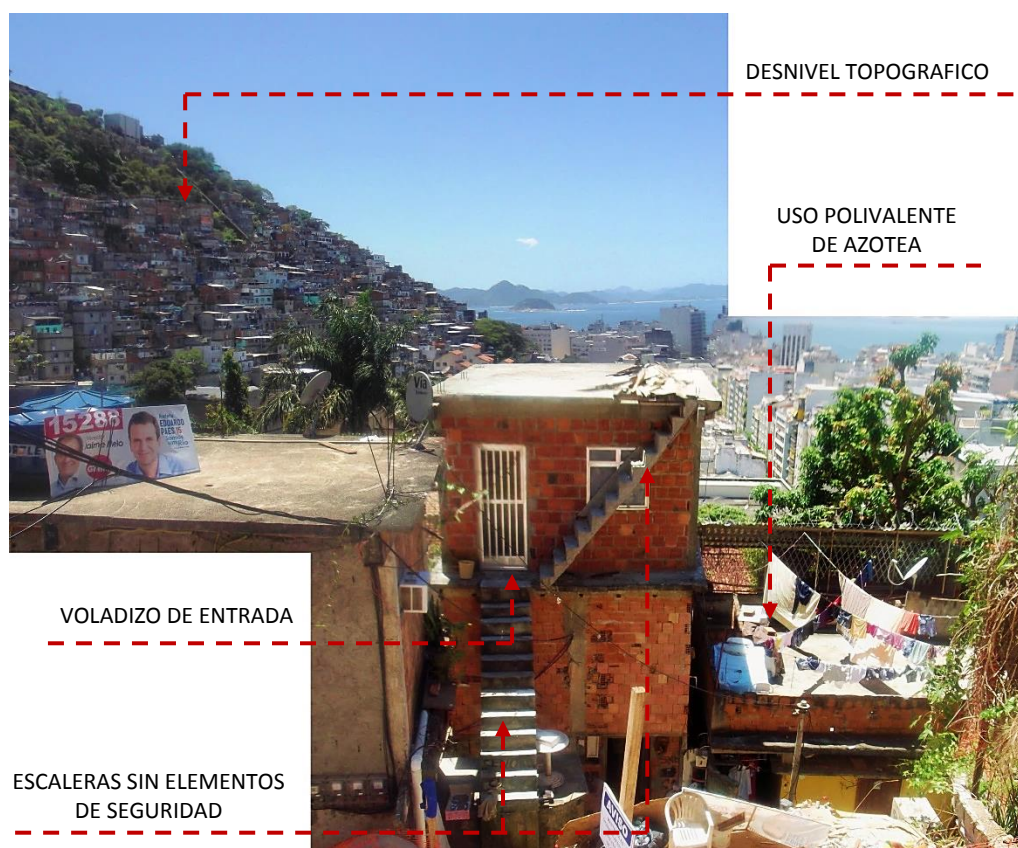
Fig. 5.73 Fotografía de barraco que permite comprobar el uso polivalente de las azoteas y como la construcción de las mismas prevalece sobre la ventilación de la vivienda -prueba de ello es la escalera solapando la ventana que da acceso a la parte superior de la edificación-. Asimismo se verifica la falta de elementos de seguridad en las escaleras, así como el voladizo de pequeñas dimensiones que sirve de entrada a la vivienda.
