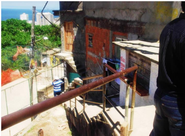
Fig. 5.95 Fotografía de escaleras “pública” con elemento de seguridad que se bifurca en una escalera “privada” de dos tramos para dar acceso -una vez más- a las viviendas situadas en cotas superiores de la vía principal
