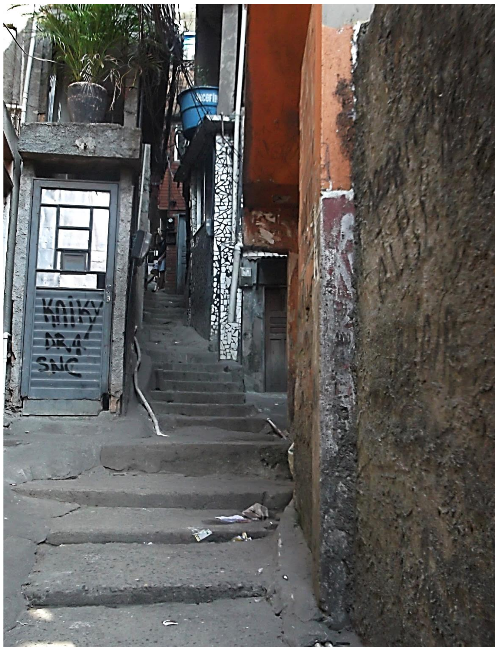
Fig. 5.156 Fotografía de escaleras con irregularidad en su trazado y preocupación por la estética del espacio urbano visible en la colocación de la maceta.
