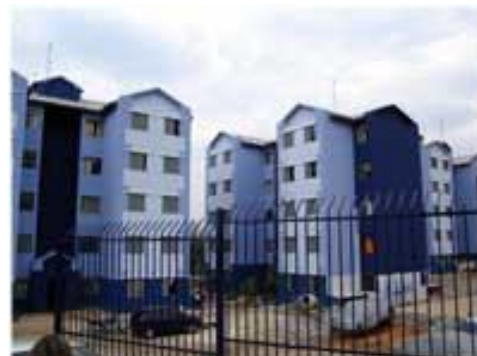
Fig. 4.6 Unidades habitacionales de Cingapura, con tipología repetida a lo largo del conjunto.
