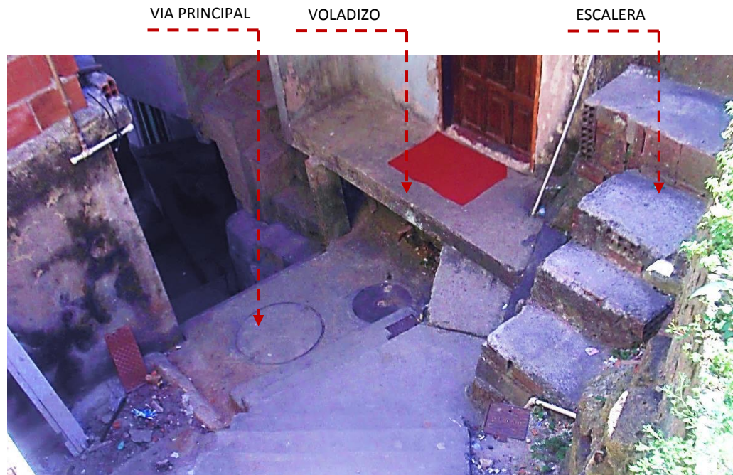
Fig. 5.46 Acceso a vivienda localizada en una cota superior a la vía trazada. Para su solución se han construido un voladizo y un tramo de escaleras que facilitan la entrada.
