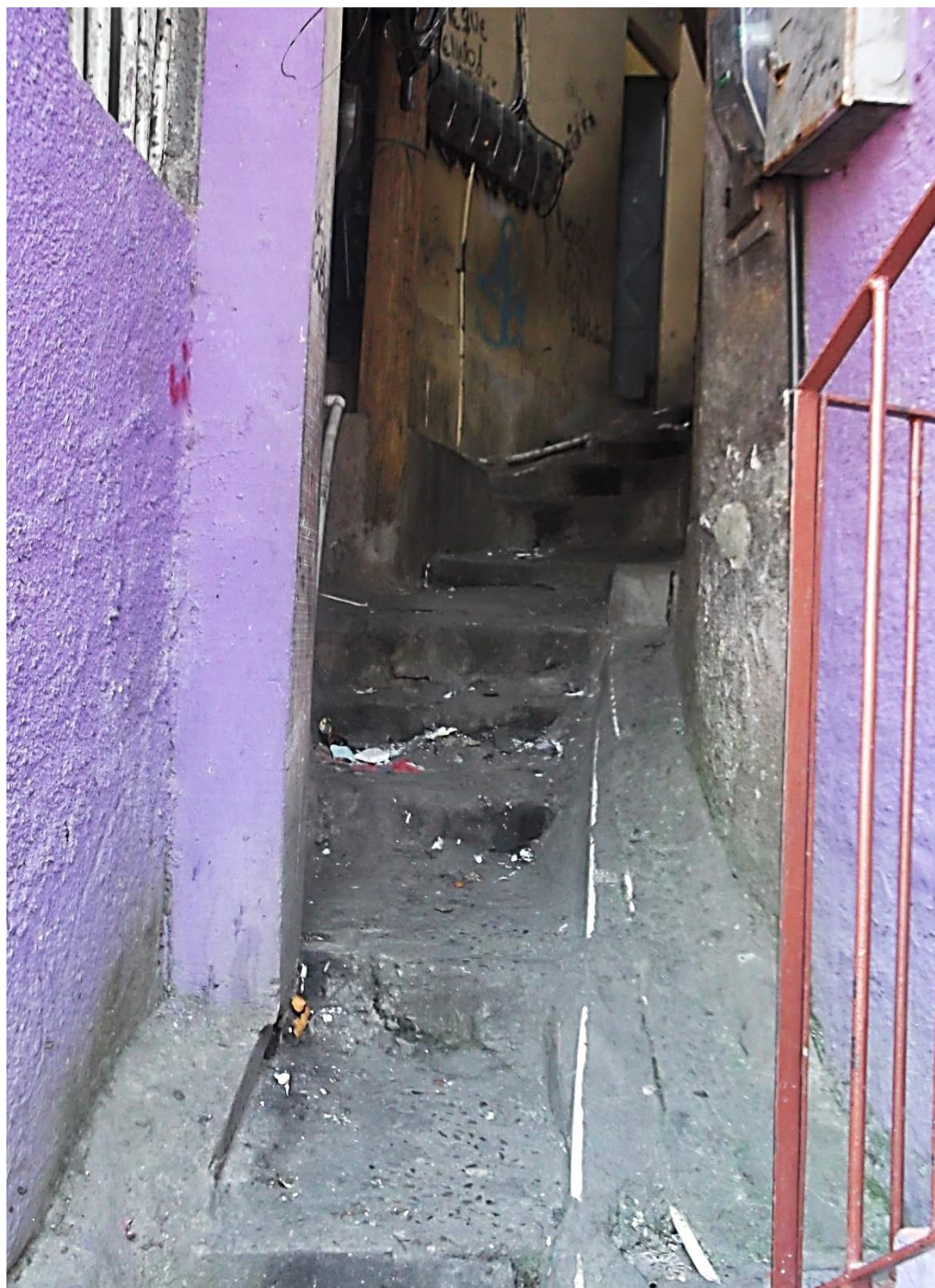
Fig. 5.154 Fotografía de viela formada por escaleras que presentan un importante deterioro visible en la irregularidad de sus escalones.
