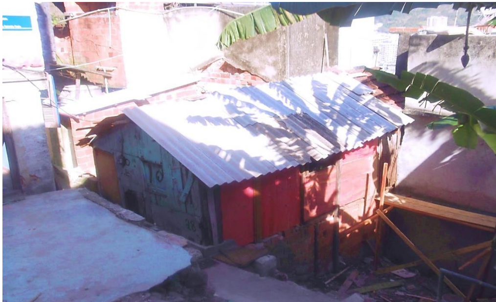
Fig. 5.28 Barraco de madera y emplazamiento de otro que ha sido destruido ambos situados en una cota inferior a la vía pavimentada.
