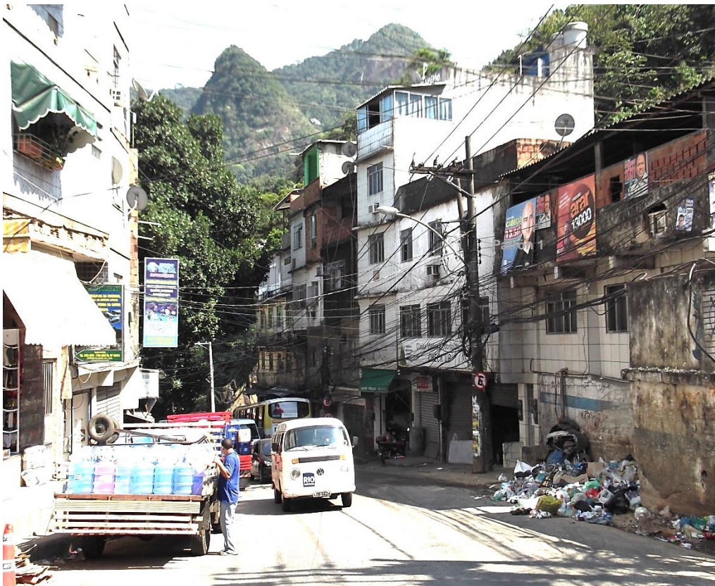
Fig. 5.129 Fotografía del patrón de eje principal formada por construcciones de varias plantas y concentración de equipamientos de comercio en la planta baja de las edificaciones.
