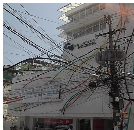
Fig. 5.122 Fachada Biblioteca C4 donde se constata la simpleza de la edificación favoreciendo su integración al entorno.
