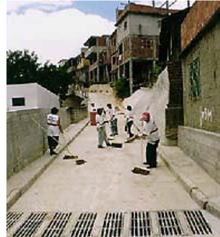
Fig. 4.2 Vías después de la urbanización, donde se identifican aceras y vía para tráfico rodado con drenaje para las aguas.
