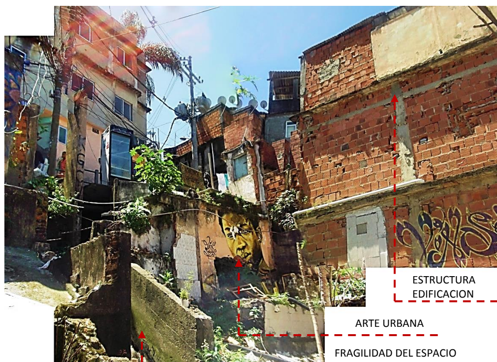
Fig. 5.74 Fotografía de espacio urbano donde se observa -en la parte izquierda superior- una edificación en la etapa final de su transformación y -en la parte derecha- otra construcción en proceso.
