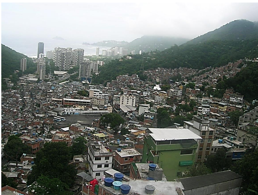
Fig. 5.115 Densificación constructiva de la Rocinha que contrasta con la calidad de São Conrado atestiguando la segregación urbana presente en Río de Janeiro.
