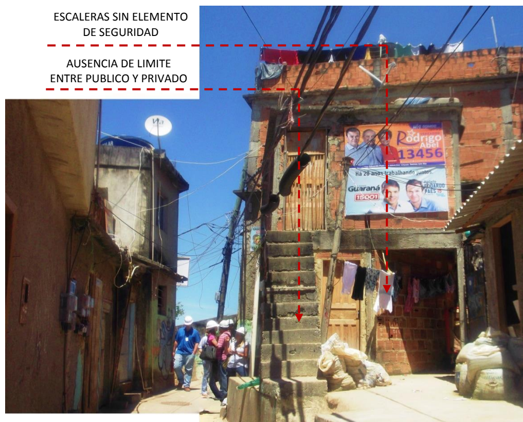
Fig. 5.92 Fotografía de espacio urbano que describe las dimensiones de la vía permitiendo la circulación de tráfico rodado, escaleras sin elemento de seguridad e imprecisión ente espacio público y privado.
