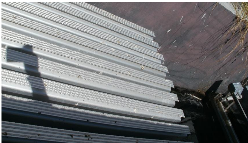
Figura 45 - Sistema de desinfecção UV da ETAR Norte de Leiria/Coimbrão
