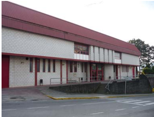
Imaxe 91: (18) Fotografía do pavillón polideportivo de Rianxo. (2012)
