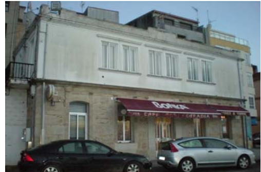
Imaxe 82: (9) Foto do Bar e antigo edificio da Confraría de Pescadores. (2012)
