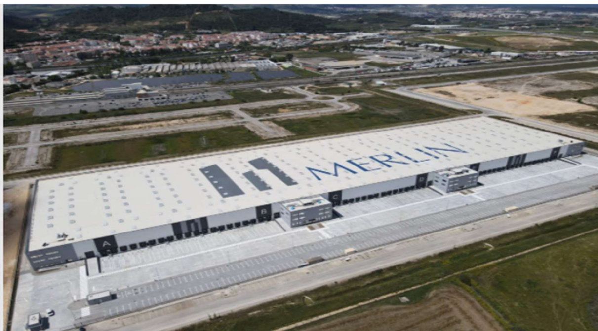
Figura 168: PLLN já construído.
