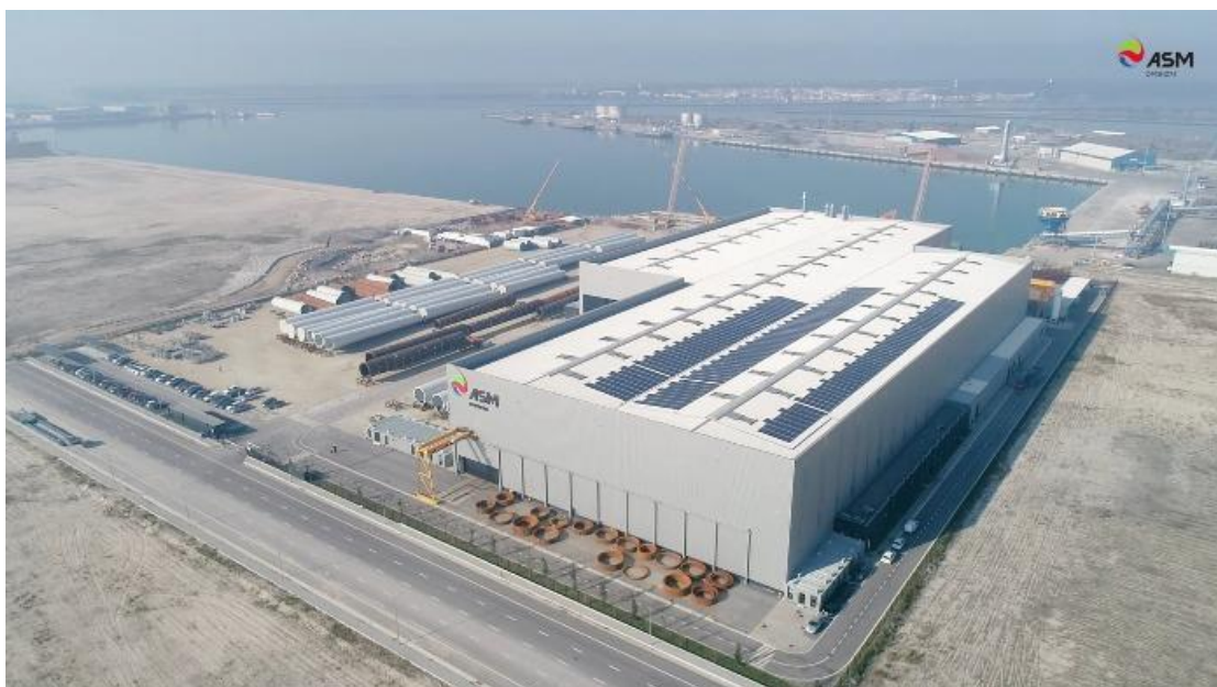
Figura 5 - CS WIND PT OFFSHORE antes da Expansão
