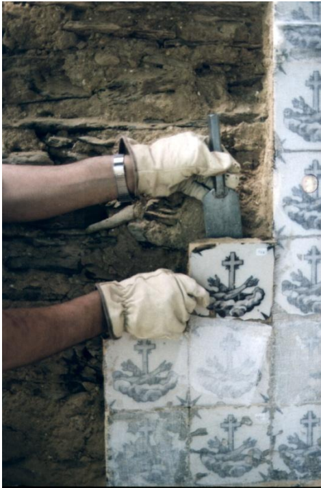
Remoção de azulejos após aplicação do faceamento
