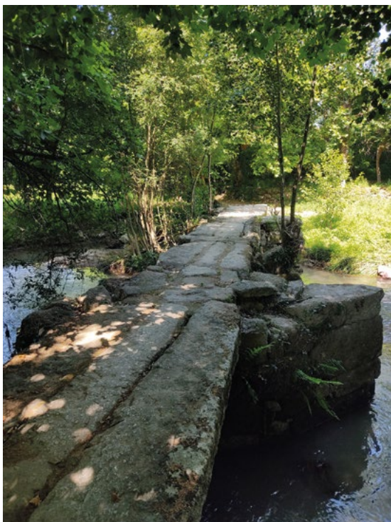
Figura 5. Vista de ponte sobre a ponte de padieiras de Casais, Meinedo (2023).
