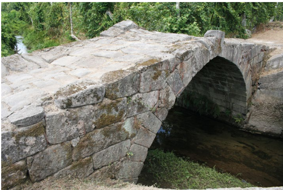
Figura 9. Ponte da Veiga, Torno. Perspetiva obtida de montante (2020).
