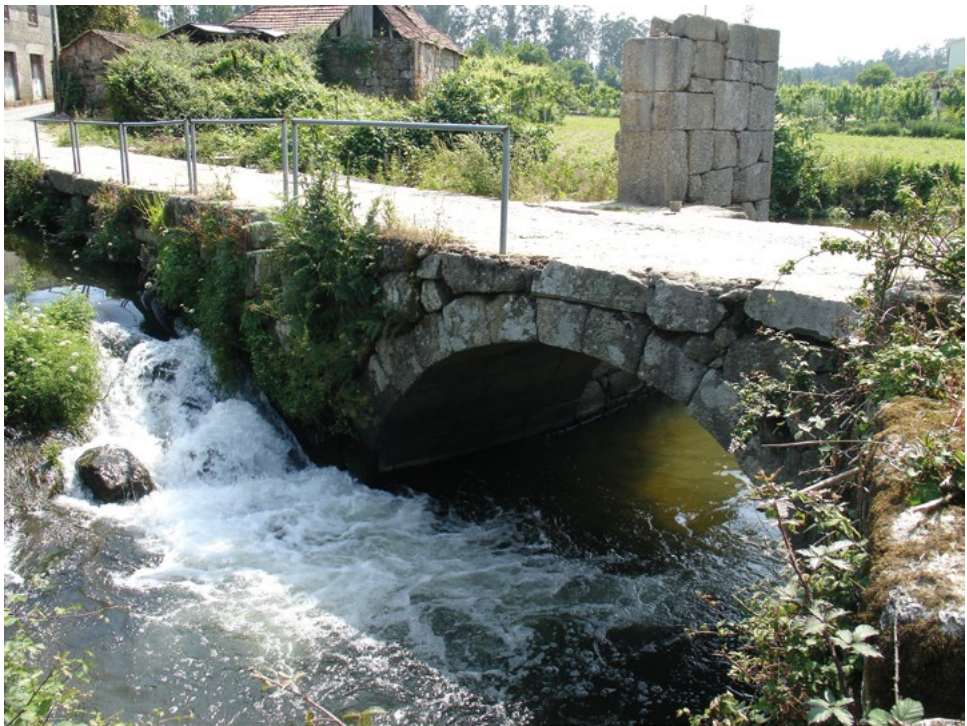
Figura 4. Ponte de Sousa sobre o rio Sousa, Lodaes. Perspetiva de montante (2007).
