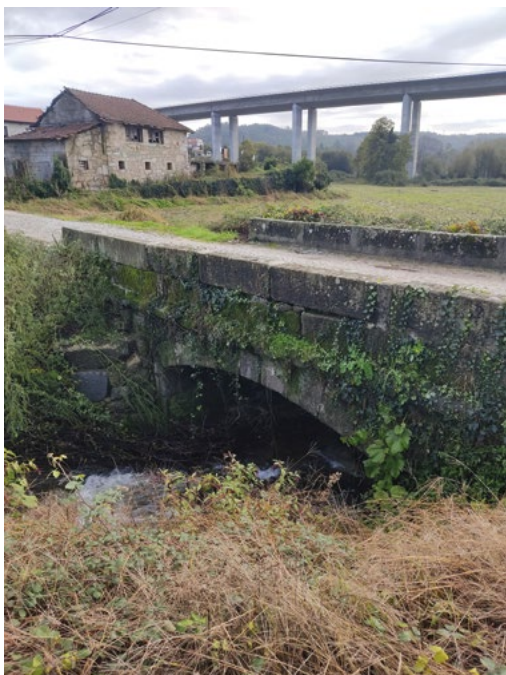
Figura 8. Ponte de Eira Vedra, Sousela. Vista de montante (2023).
