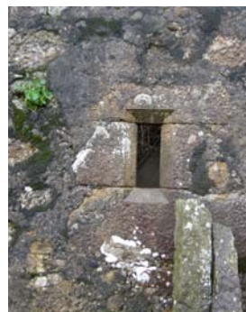
Bufarda en planta terrena. Casa nº 25
