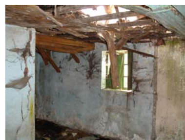
Vista de la primera planta.
