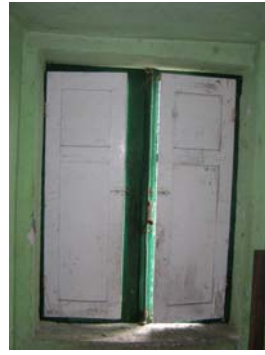
Ventana y contraventana exterior. Casa nº 93
