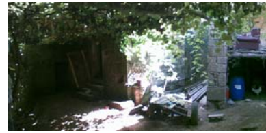
Entrada principal a la vivienda.
