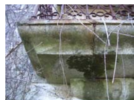
Balcón. Casa nº 260
