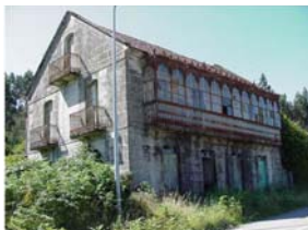
Galería hierro. Casa nº 153.
