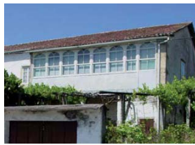
Galería madera. Casa nº 167
