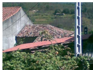
Cubierta de la casa vista desde el camino de acceso.
