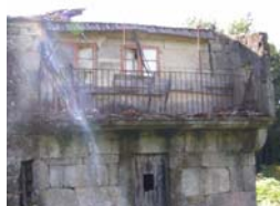
Balcón. Casa nº 67
