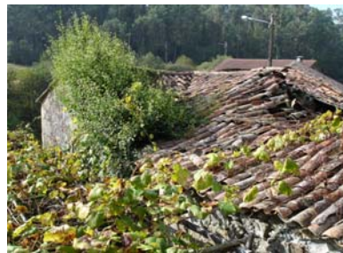
Vista de la fachada sur.
