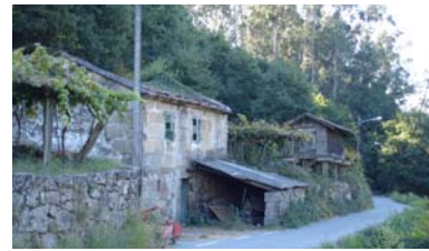
Vista de la fachada oeste.
