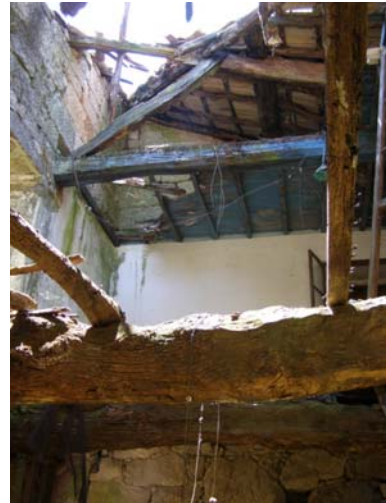
Detalle de los forjados y cubierta.
