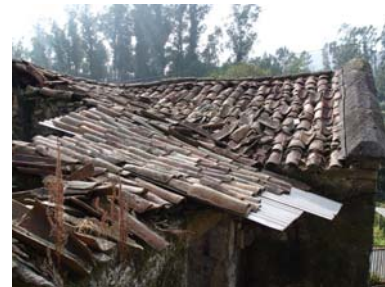
Vista de la fachada norte.
