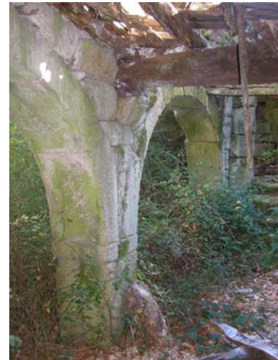
Detalle de la arcada.
