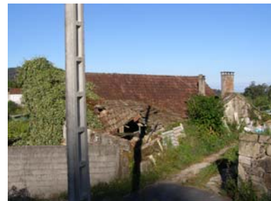
Vista del Noroeste de la casa.
