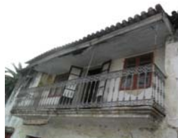
Balcón. Casa nº 117
