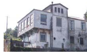
Galería ladrillo. Casa nº 206.
