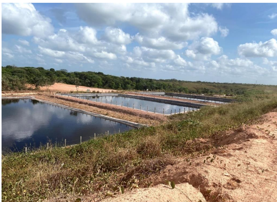
Figura 19-Três lagoas do líquido percolado do aterro (Acervo Pessoal, 2022).
