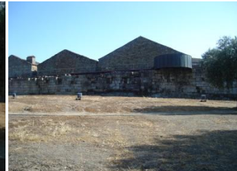
[Fig. 81] Vista sobre a nova intervenção
