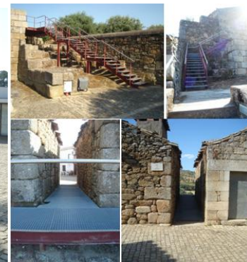
[Fig. 59] Acessos à nova plataforma
