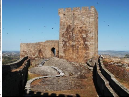
[Fig. 3] Intervenção: circuito pedonal
