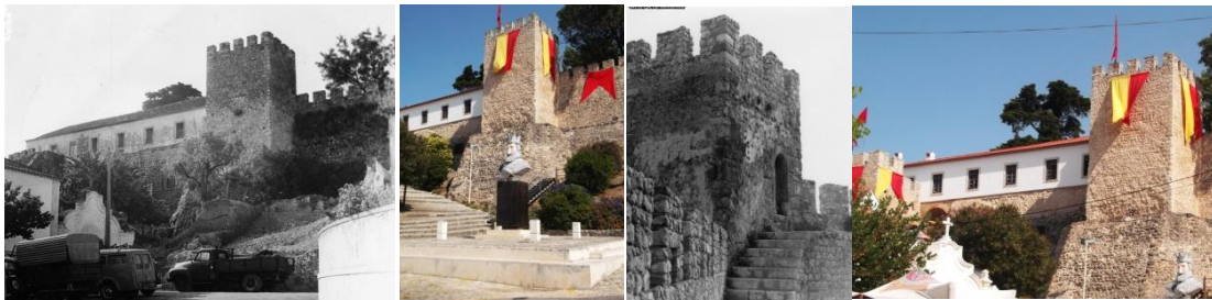
[Fig. 91] Antes da intervenção
