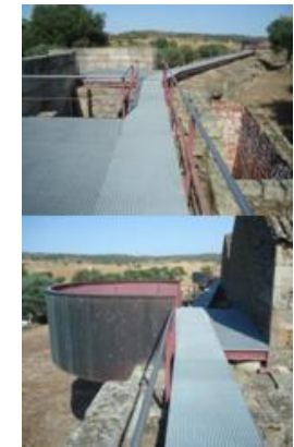
Plataforma metálica (autor)
