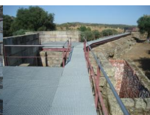
[Fig. 66] Plataforma metálica
