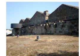
Intervenção na muralha (autor)
