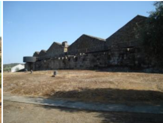
[Fig. 80] Vista sobre a muralha
