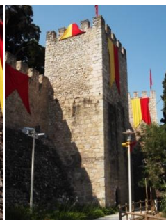
[Fig. 89] Torre Norte
