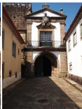
[Fig. 131] Acesso principal
