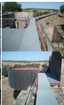
[Fig. 53] Plataforma metálica
