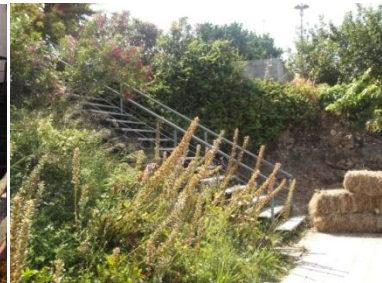
[Fig. 113] Escadarias Metálicas
