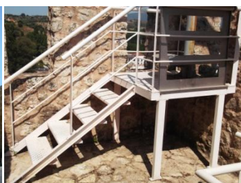
[Fig. 104] Estrutura Metálica
