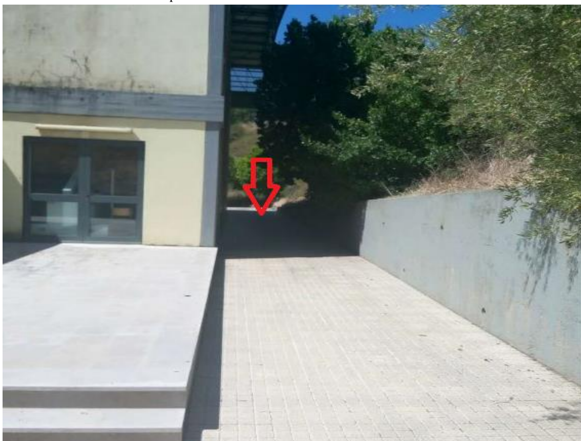
Foto 6 – Corredor de difícil supervisão
