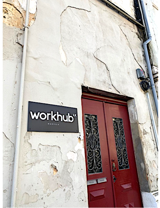
Fig.37 – Fachada do edifício no qual está instalado o Workhub. Fonte: Autora
