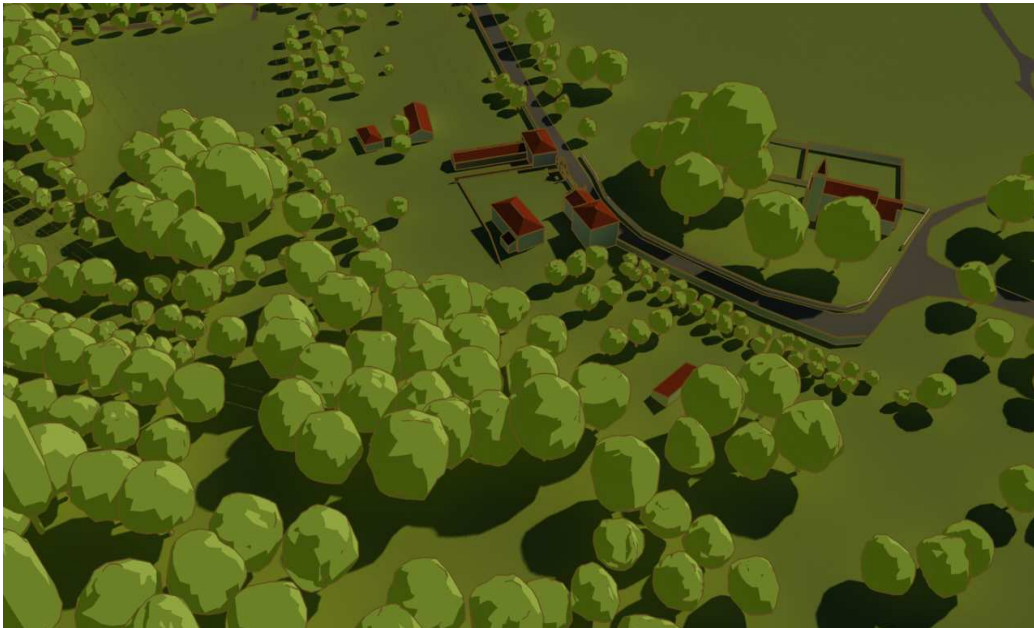
Fig. 21 A e 21 B. Quinta do Amparo: situação actual (Modelo 3 D, elaborado arq. Paulo Alcobia)
