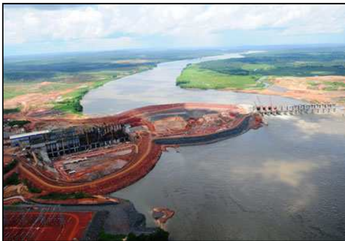
Foto 1: Processo de edificação da barragem da UHE - Estreito. Fonte: http://www.uhe-estreiro.com.br , acessado em 02/05/2011
