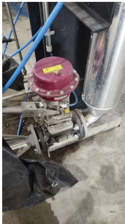
Figura 33 - Válvula Valsteam VPA46/2.
