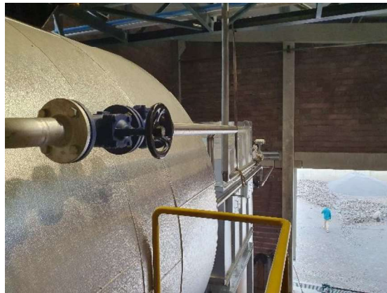
Figura 29 - Válvula de Globo DN65 PN16 na alimentação de água ao G.V.
