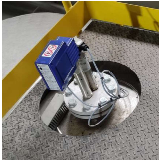
Figura 24--Montagem de ambos os elétrodos no corpo de pressão
