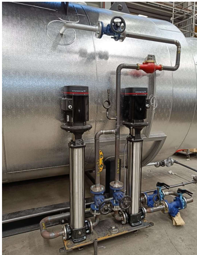
Figura 39 - Pré-montagem de um grupo de bombagem em fábrica.
