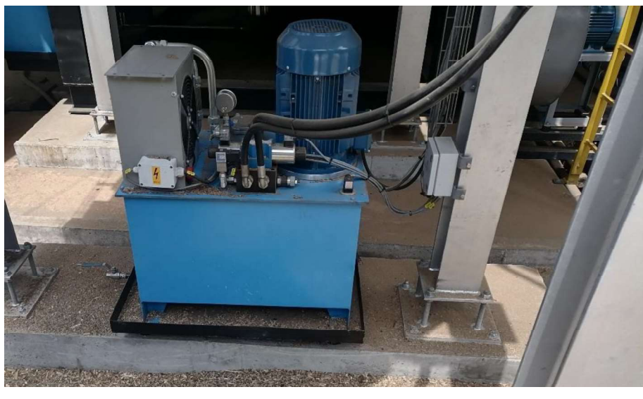
Figura 43 - Unidade hidráulica do alimentador.
