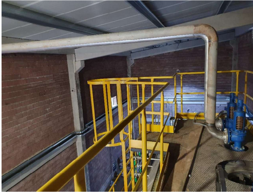
Figura 30 - Válvulas de segurança Leser DN80 125 PN16.
