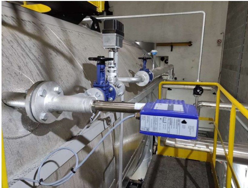
Figura 27 - Sonda LRGT 16-3 + Válvula BAE 46-3.
