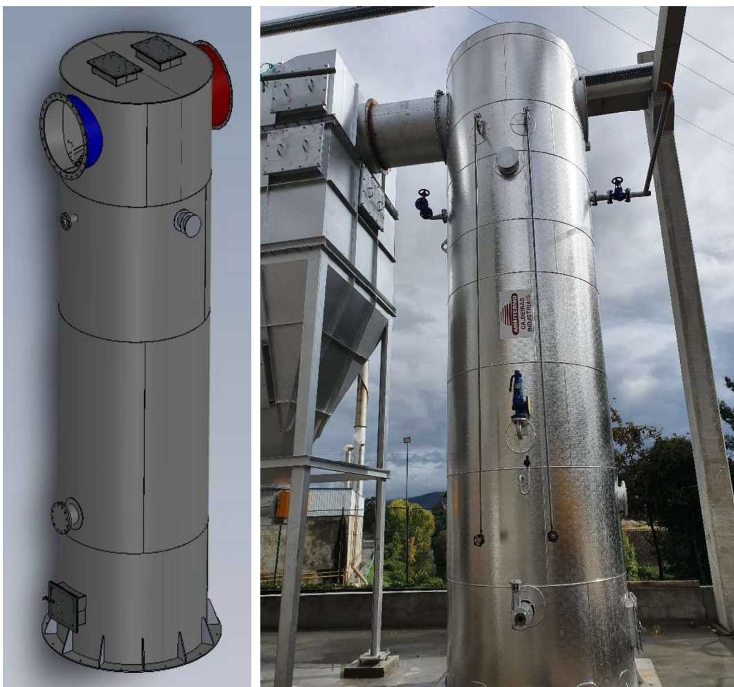
Figura 14 - Economizador de calor gastubular.
