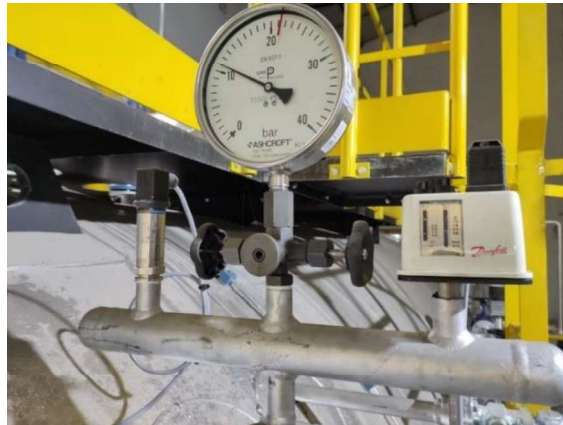
Figura 21 - Montagem do equipamento de medição e controlo de pressão
